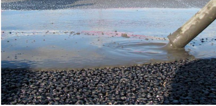
Şekil 1. 1. Yarı Rijit Kaplama Uygulaması (Randy 2007)
