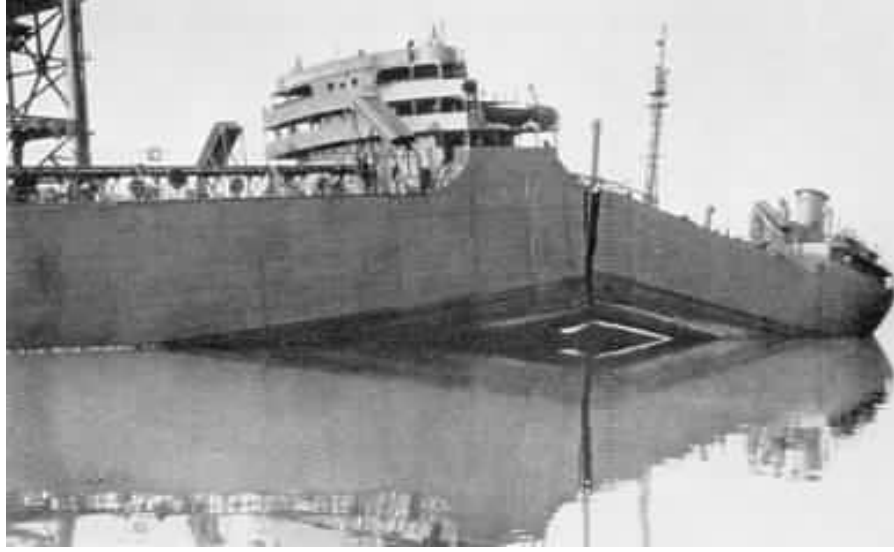
Şekil 3.2. S.S. Schenectady adlı tankerin gevrek kırılması [42]
