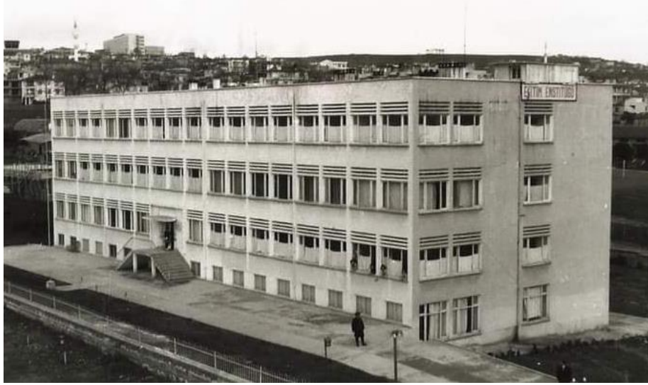
Şekil 3.17. Samsun Eğitim Enstitüsü binası (Altansoy, 2022)
