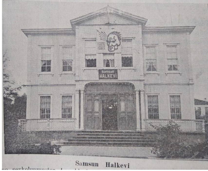
Şekil 3.5. Samsun Halkevi Binası (Samsun Halkevi Çalışmaları, 1939)
