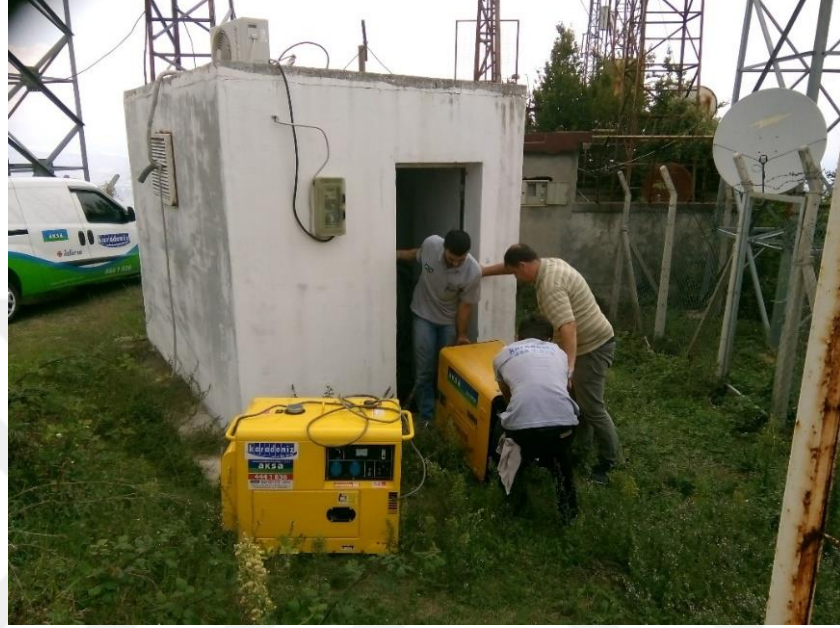
Şekil 3.50. Verici kulübesi jeneratör bakımı
