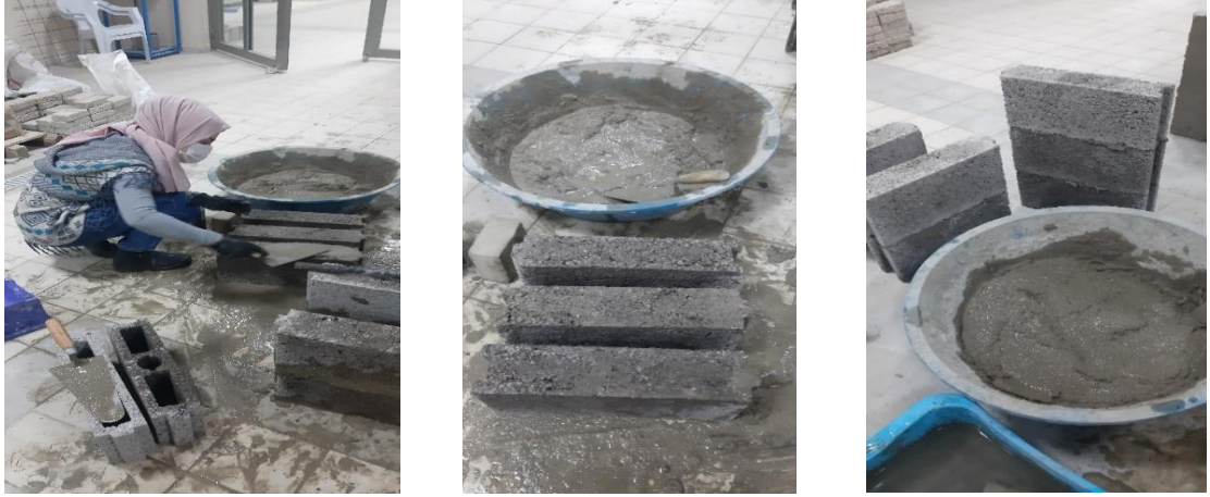
Şekil 3.23. Atık pomza tozu içeren harçlarla 2'li ve 3'lü blok duvar numunesi hazırlık çalışmalarından görüntüler.
