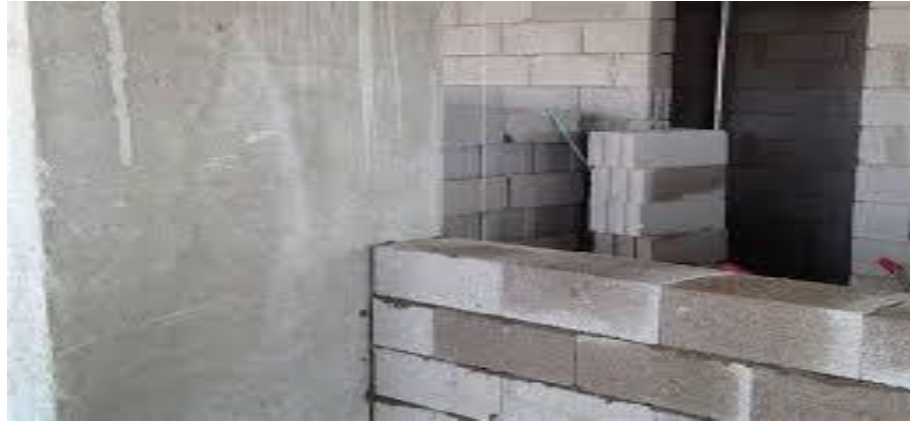
Şekil 1.7. Blokbims duvar örneği
