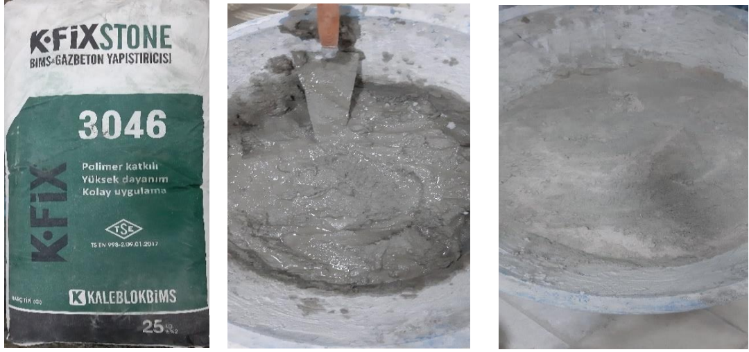
Şekil 3.15. K-Fix Stone yapıştırma harcının hazırlanması
