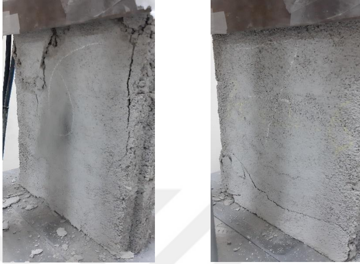
Şekil 4.27. ÇP1_5 ve ÇP1_7 pomza tozu harcı kullanılarak imal edilen 3'lü sıvalı blok numunelerin basınç dayanım deneyi sonu örnek görüntüleri.
