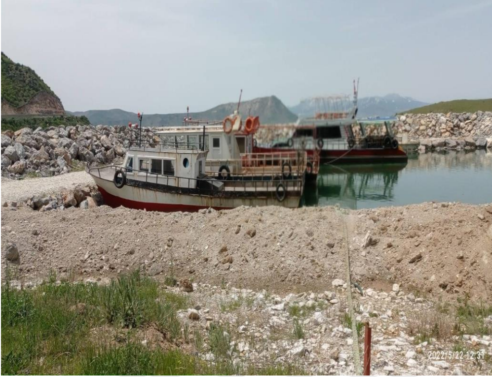
Şekil 3.2. Reşadiye balıkçılık kıyı yapısı-1 (Fotoğraf: Necati Önal).
