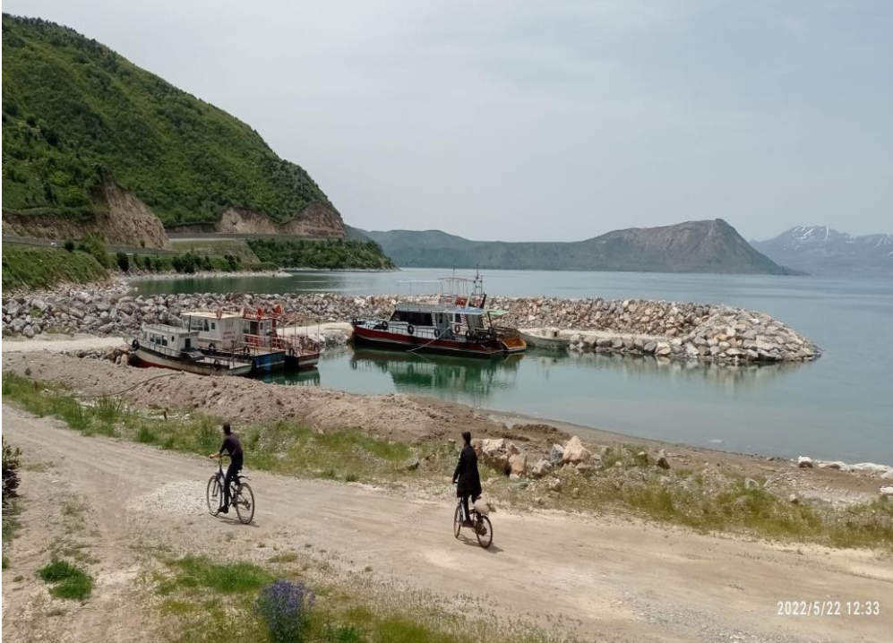
Şekil 3.3. Reşadiye balıkçılık kıyı yapısı-2 (Fotoğraf: Necati Önal).
