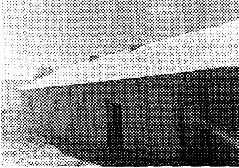
Resim 1. Duvarları briketten yapılmış sıvasız bir barınak.
