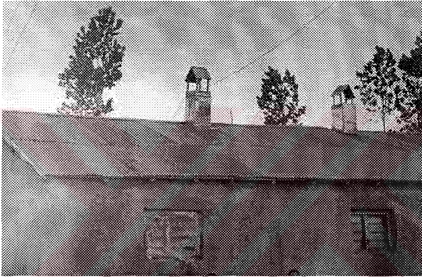
Resim 5. atıda havalandırma bacası bulunan bir barınak
