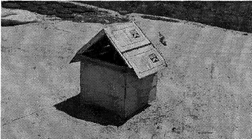
Resim 6. atı örtüsü toprak olan bir barınakta havalandırma bacası.
