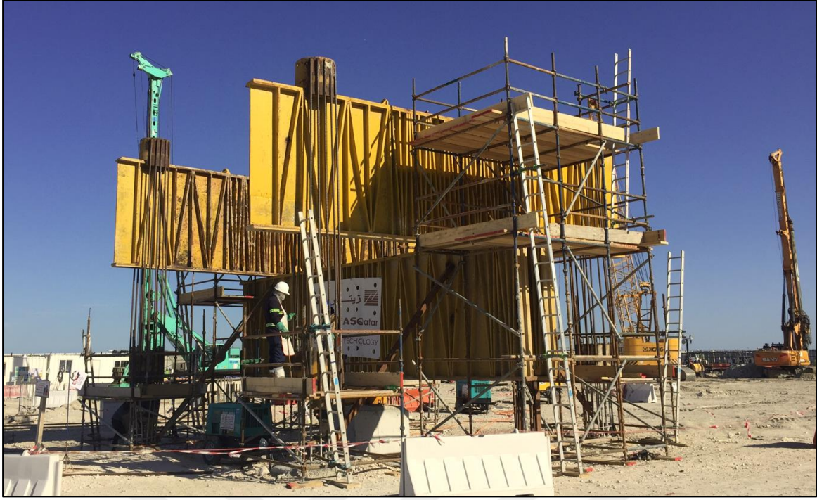
Şekil 5.13 : Vaka analizine ait kazık yükleme test düzeneği – 2 (projesinden alınmıştır).
