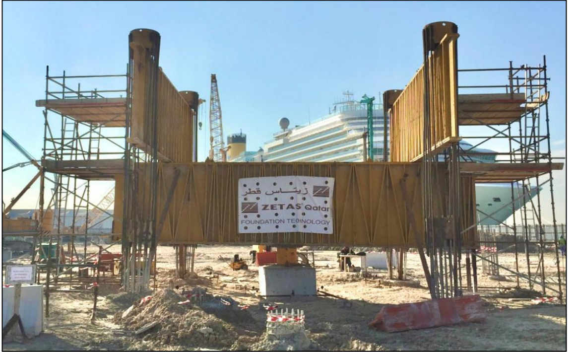
Şekil 5.12 : Vaka analizine ait kazık yükleme testi düzeneği (projesinden alınmıştır).
