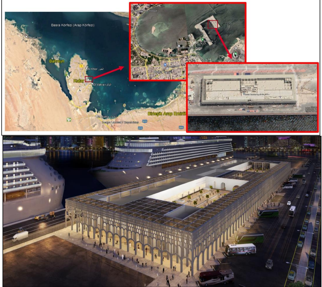
Şekil 5.1 : Uygulama sahasının yeri ve inşa edilecek yapının genel görünümü (Projesinden alınmıştır)
