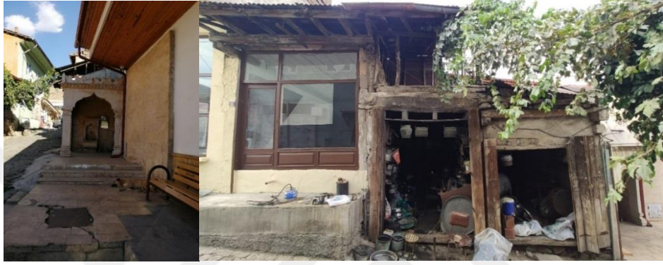
Şekil 126: Kültür Cami Şadırvanı ve Komşu Yapılar, (Kişisel Arşiv,2021)
