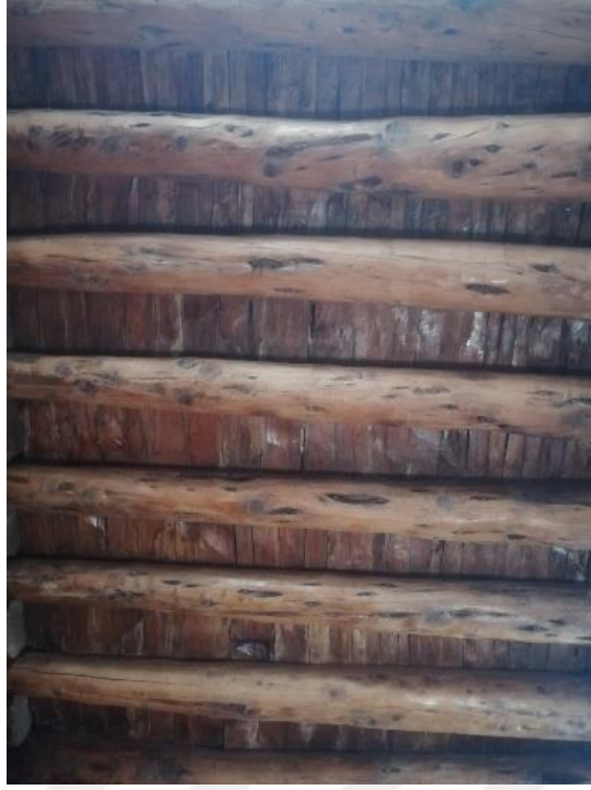
Şekil 130: Abuçimen Cami Tavan Döşemesi, (Kişisel Arşiv, 2022)
