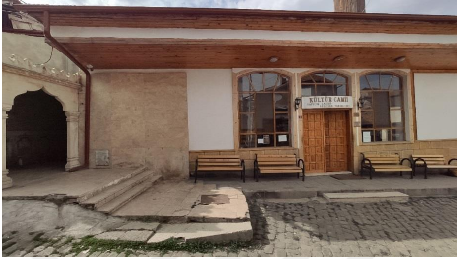
Şekil 84: Kültür Cami Kuzey Cephesi, (Kişisel Arşiv,2021)
