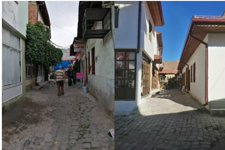
Şekil 127: Sokak Sağlıklaştırma Çalışması Öncesi Ve Sonrası, (Kişisel Arşiv,2021-2022)
