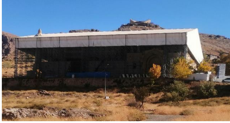
Şekil 41: Divriği Ulu Camii Restorasyon Çalışmaları Devam Ederken, (Kişisel Arşiv, 2022)
