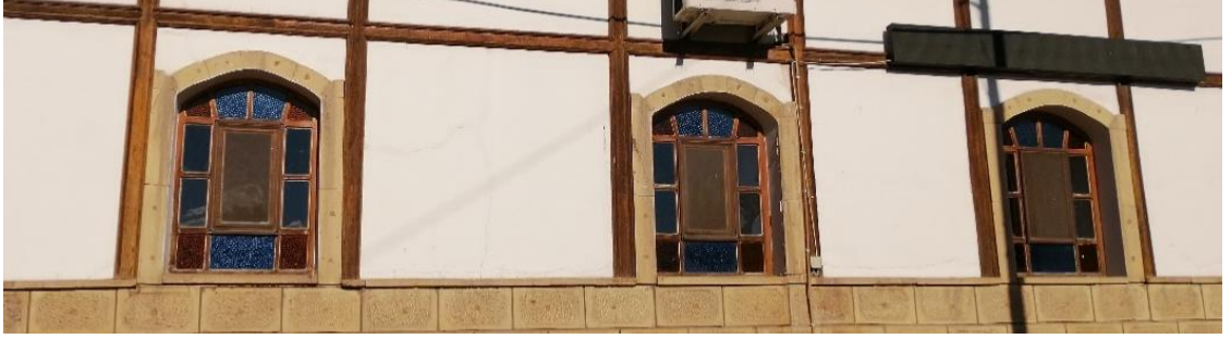
Şekil 120: Kültür Cami Batı Cephesi Doğramaları, (Kişisel Arşiv,2021)
