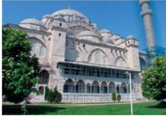
Şekil 35: Süleymaniye Cami Restorasyon Uygulamaları Sonrası Doğu Cephenin Görünümü, (Ersen, Olgun ve ark. 2011)
