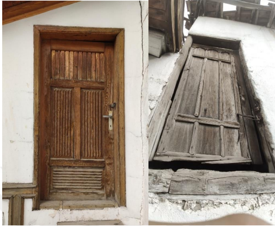
Şekil 118: Doğu Cephesi Kalkan Duvarı Üzerine Bulunan Çatı Giriş Kapısı, 122 Ada 8 Parsel (Komşu Parsel) Çatı Giriş Kapısı, (Kişisel Arşiv,2021)
