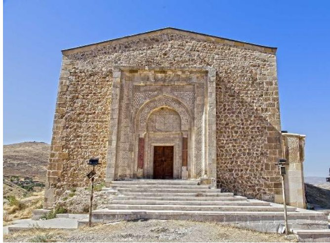
Şekil 42: Kale Camii Görünüşü, (Kişisel Arşiv, 2022)
