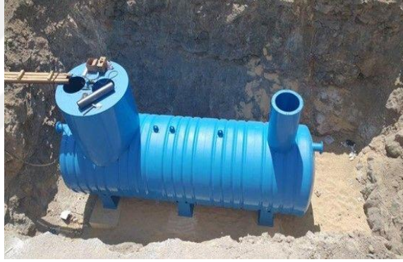
Şekil 4. Yer Altı Yağmur Suyu Depolama Tankı [8]
