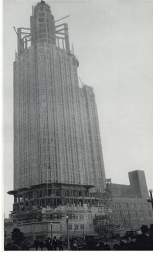
Şekil 4 24 Tribün Kulesi İnşa Halinde, Şikago, Fotoğraf Erich Mendelsohn.
