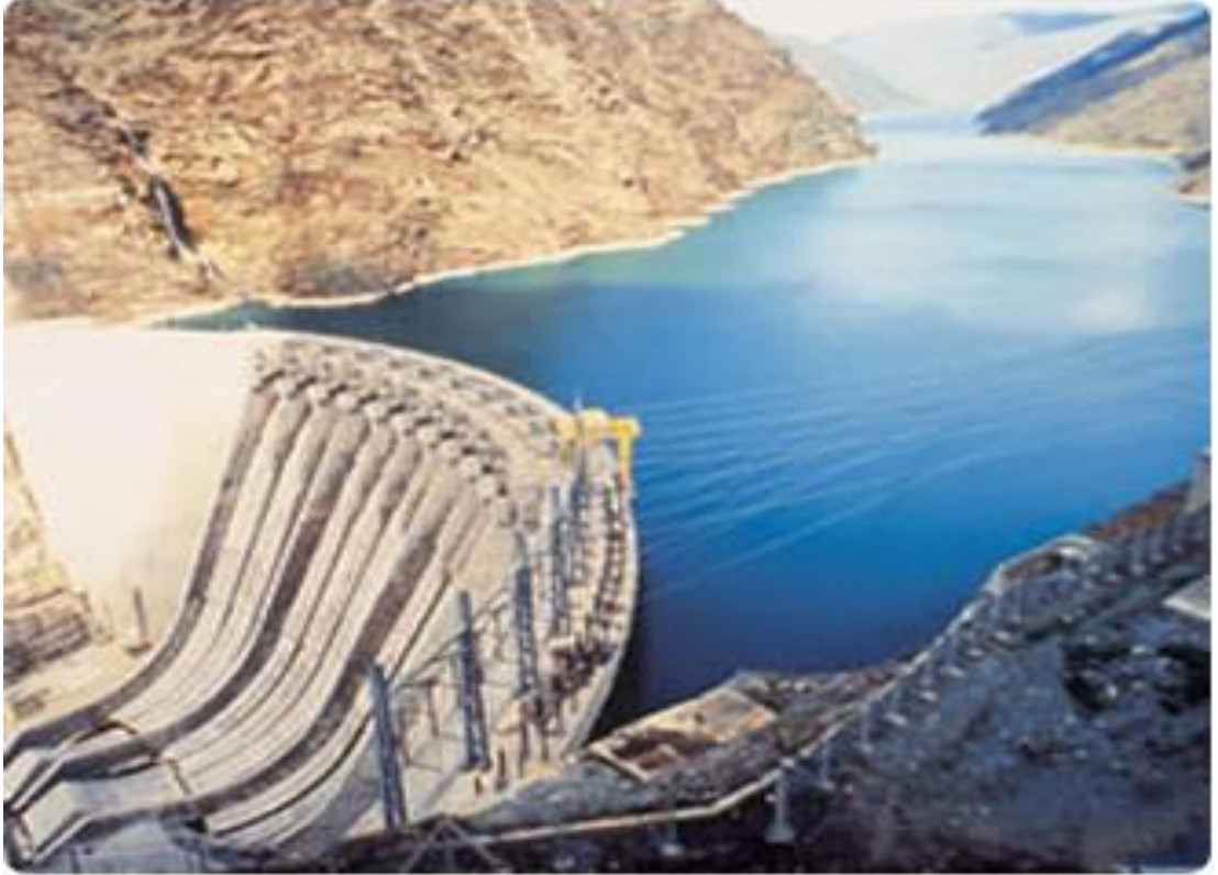
Şekil 2.8. Hidroelektrik enerji santrali ( https://www.enerjiatlası.com/hidroelektrik/karakaya-barajı.html )
