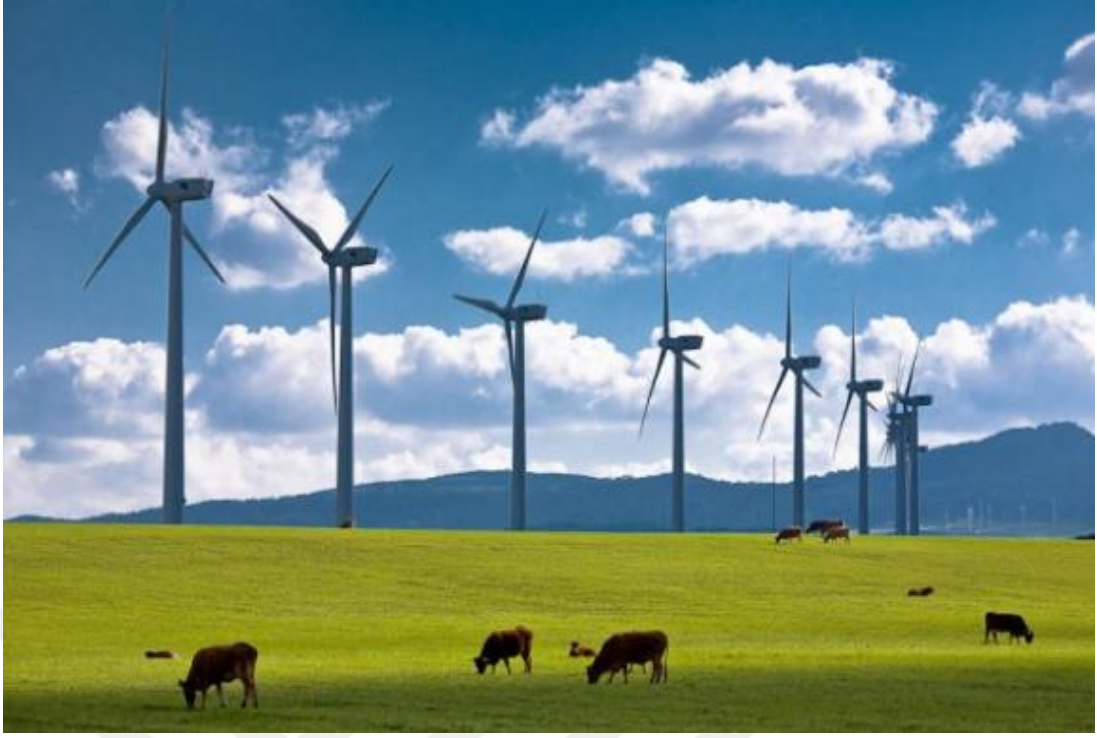
Şekil 2.1. Rüzgâr enerji santrali ( https://www.powerenerji.com/turkiyede-kurulu-ruzgar-enerji-santralleri-elektrik-uretimi-haritasi.html )
