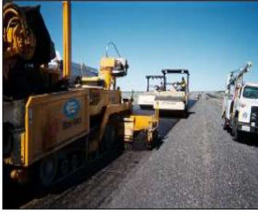
Silindirler finişere yakın tutulur.
