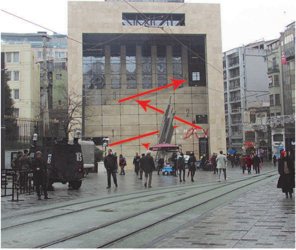
Şekil 3.51 Sokaktan algılanan şeffaf kuzey cephesinin arkasındaki rampalar
