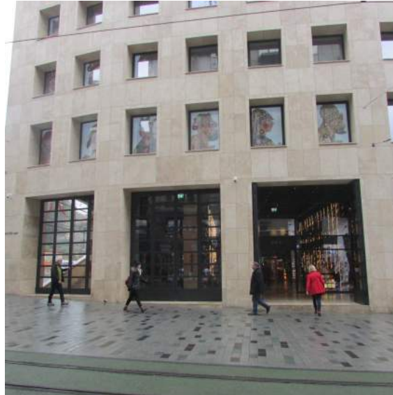
Şekil 3.53 YKKS'nin batı cephesindeki portiko
