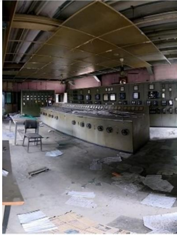
Şekil 4. 22. Fabrikanın şekil 4.20’de gösterilen 4 numaralı alanı (Kontrol Odası)
