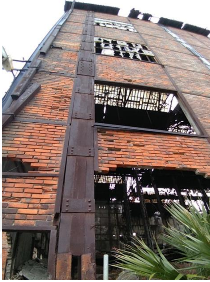
Şekil 4. 30. Elektrik Fabrikasının cephesinde devam eden strüktür
