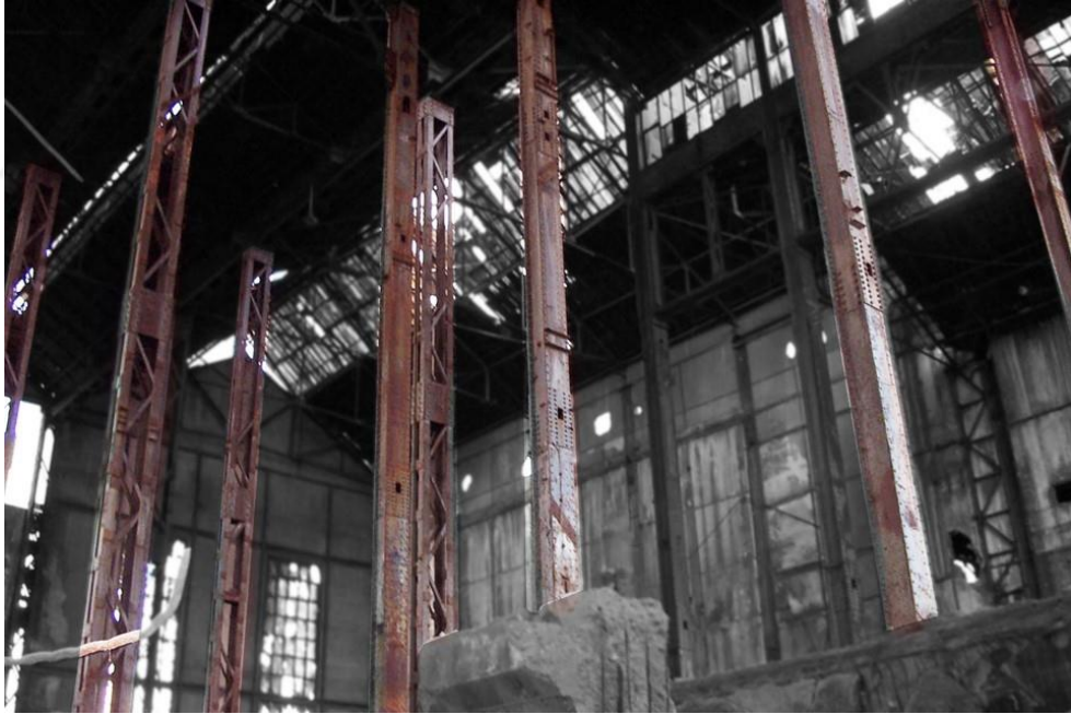
Şekil 4. 28. İzmir Elektrik Fabrikası'nın çelik taşıyıcıları
