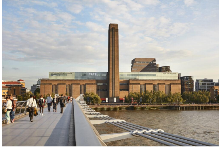
Şekil 2. 9. Yapıya Eklemlenen Yarı Saydam Alan ve Yapıya Ulaşmak İçin Tasarlanan Yaya Köprüsü
