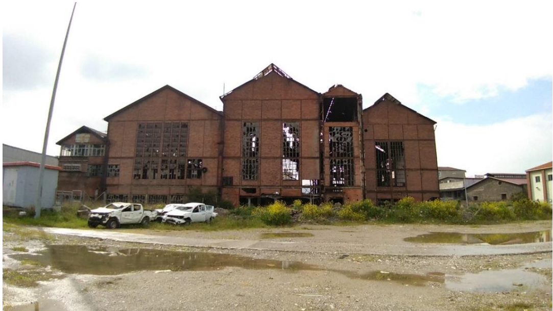
Şekil 4. 34. İzmir Elektrik Fabrikasının kuzey cephesinin günümüzden görseli
