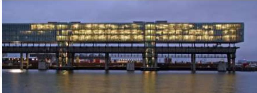
Şekil 4.18. Kranpoor Ofis Binaları Yeniden Kullanımı (URL19)
