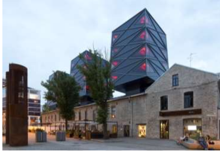
Şekil 4.26. Rotterman Marangoz Atölyesi Ön Cephesi (URL:21)
