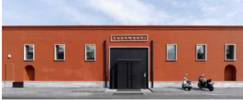
Şekil 4.30. Tuz Ambarı Cephe Görüntüsü (URL 22)
