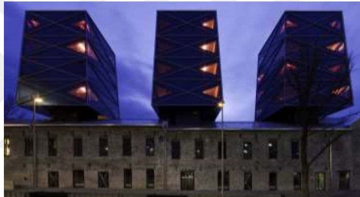
Şekil 4.27. Rotterman Marangoz Atölyesi Arka Cephesi (URL:21)
