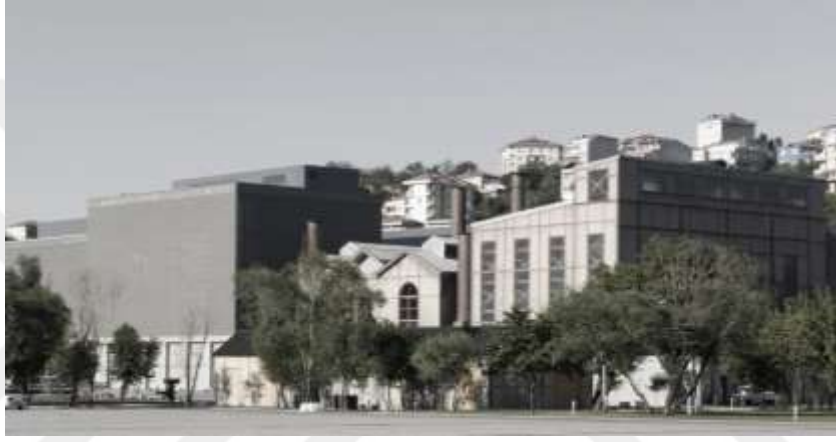
Şekil 4.36. Santral İstanbul Mevcut ve Ek Yapı (URL 23)
