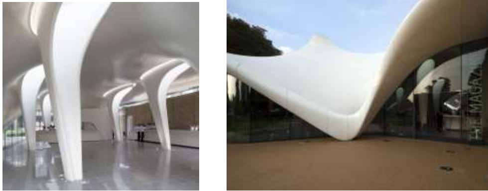
Şekil 4.22. Serpentine Sackler Galerisi Ek Ve Mevcut Yapısı Giriş Bölümü (URL20)
