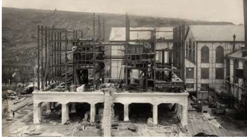
Şekil 4.35. Santral İstanbul Yapım Aşaması (URL 23)
