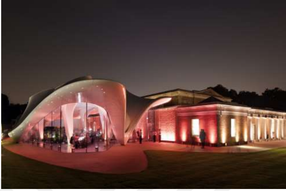
Şekil 4.23. Serpenter Sackler Galerisi Ek ve Mevcut Yapısı (URL20)
