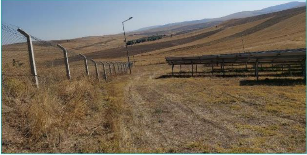
Şekil 3.25 Santralin kurulu olduğu zemin ve çevre yolları
