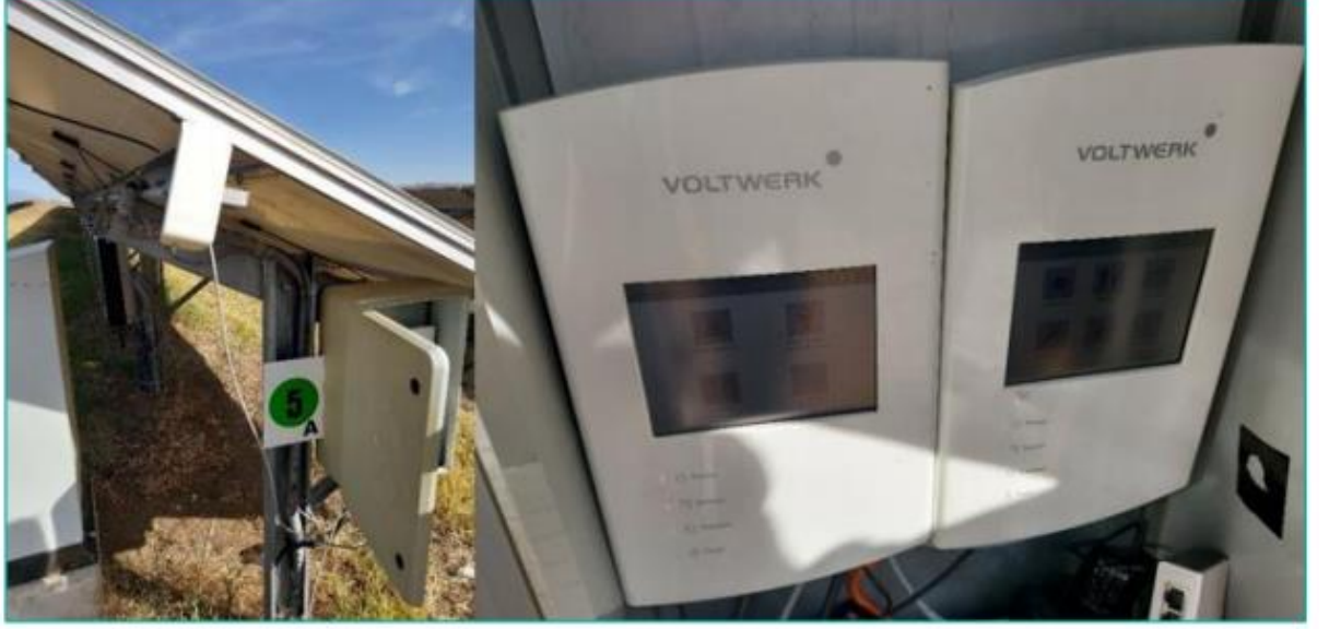
Şekil 3.34 Voltmerk evirici izleme sistemi
