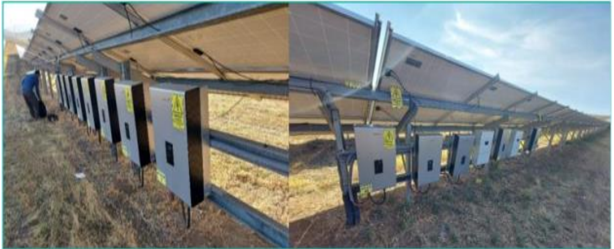
Şekil 3.33 Evirici montaj detayı
