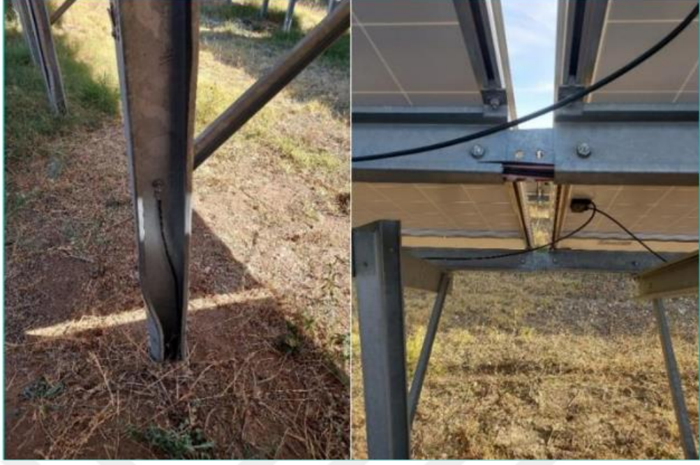
Şekil 3.26 Taşıyıcı sistem topraklama bağlantıları
