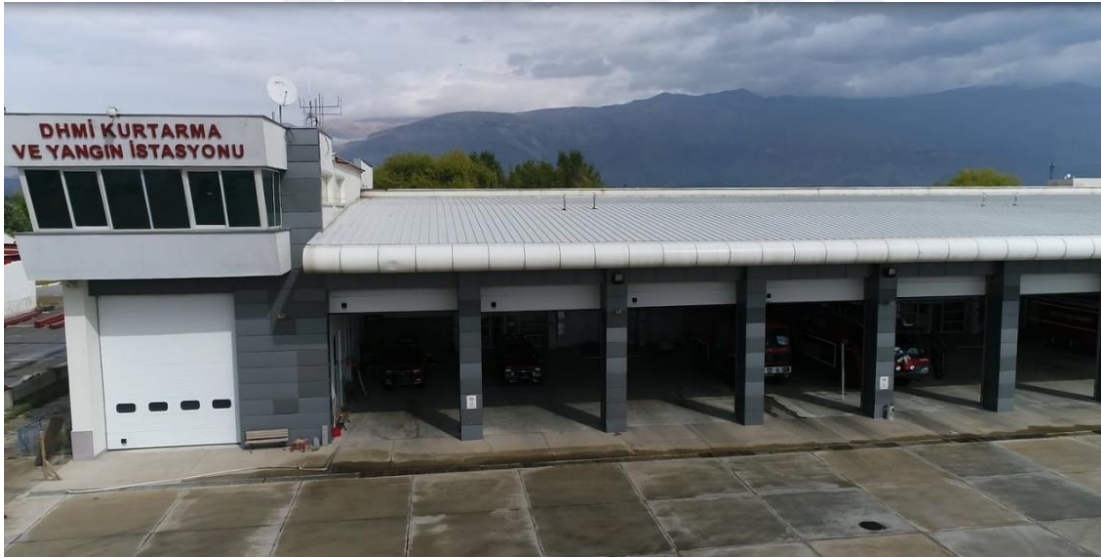
Şekil 2.2. DHMİ kurtarma ve yangın istasyonu
