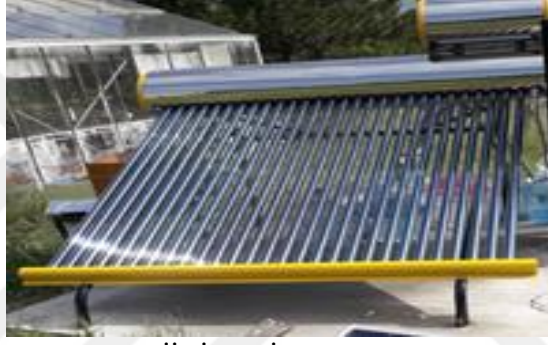
Şekil 3.2. Vakum tüplü güneş enerji sistemi
