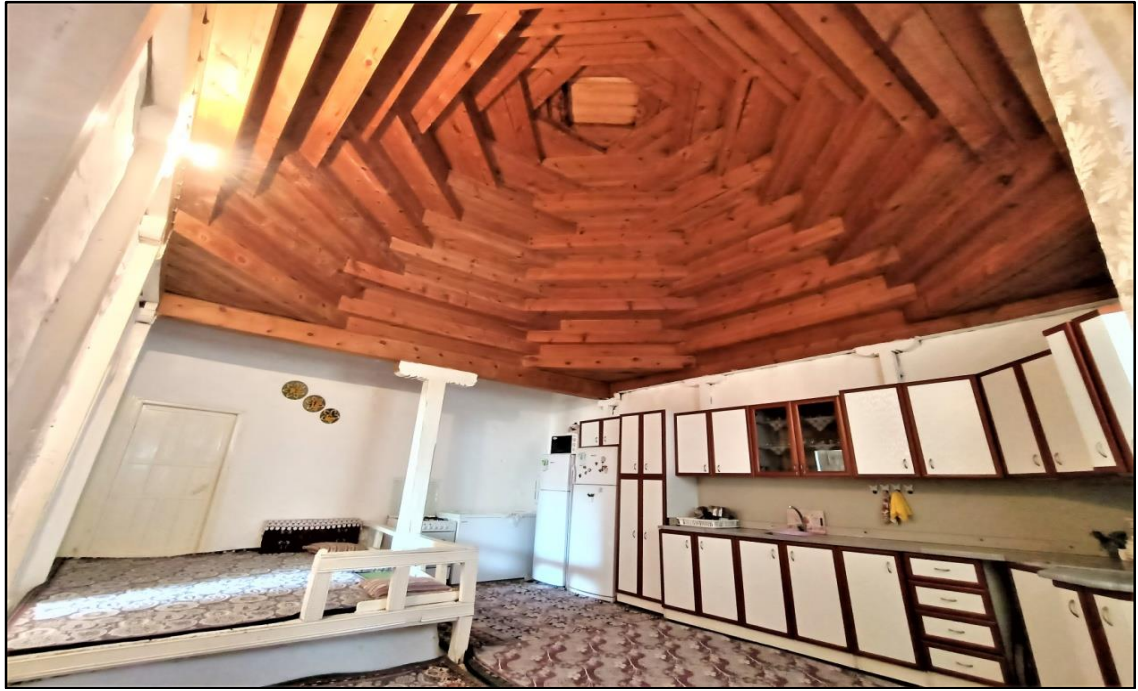
Fotoğraf 2.14. Dereboğaz Köyünde Mutfakta Bulunan Seki Olarak Adlandırılan Oturma Yeri ve Kırlangıç Çatı Örtüsü.
