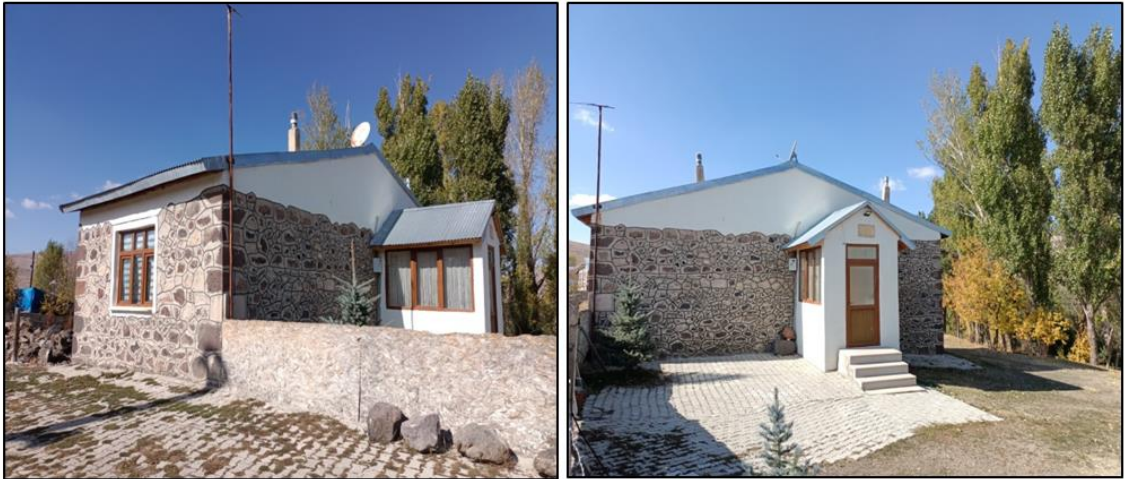
Fotoğraf 2.20. Dereboğaz Köyünde Modern Bir Şekilde İnşa Edilen Konut.
