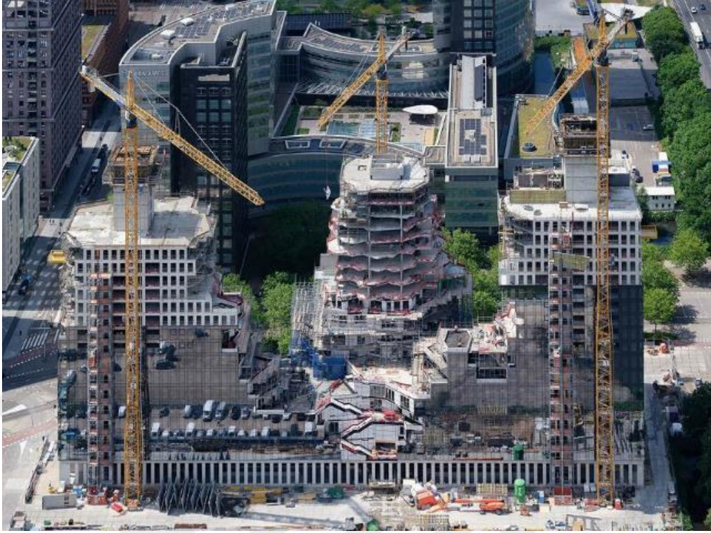
Şekil 2.32 Valley Projesi Yapım Aşaması (WEB_18,2021)
