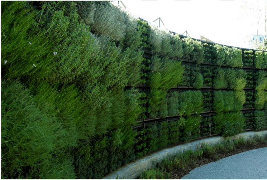
Şekil 2.7 Topraklı Panel Sistem Örneği (WEB_6,2021)
