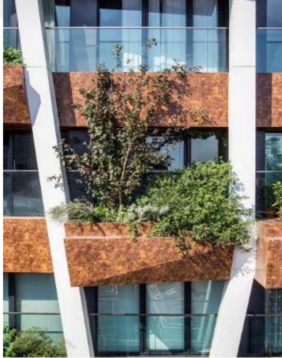
Şekil 2.34 Greenox Urban Residence Cephe Tasarımı (WEB_19,2021)
