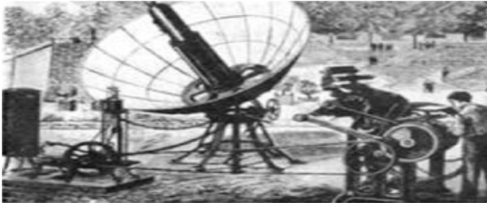
Şekil 2.3 Mouchot'un parabolik güneş kolektörü [33]
