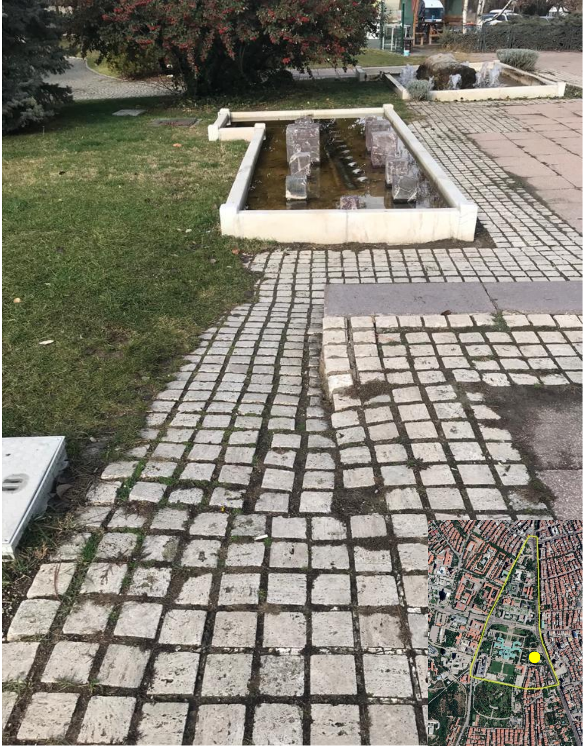
Görsel 57. ( kaynak: kişisel arşiv) Ankara Şehrinin seçilen bölgesinde (Milli Egemenlik Parkında) yeşil alan ve parklarda rampa ve merdiven uygulamasında eğim ve dönüş problemleri bulunmaktadır. Rampa bitişinde hemen havuz ile karşılaşılmaktadır. Küpeşte yoktur. Dış mekân zemininin düz, sabit olmaması ve engebeleri nedeni ile rampalı geçişe daha uygun yaklaşımlar önerilmektedir.
