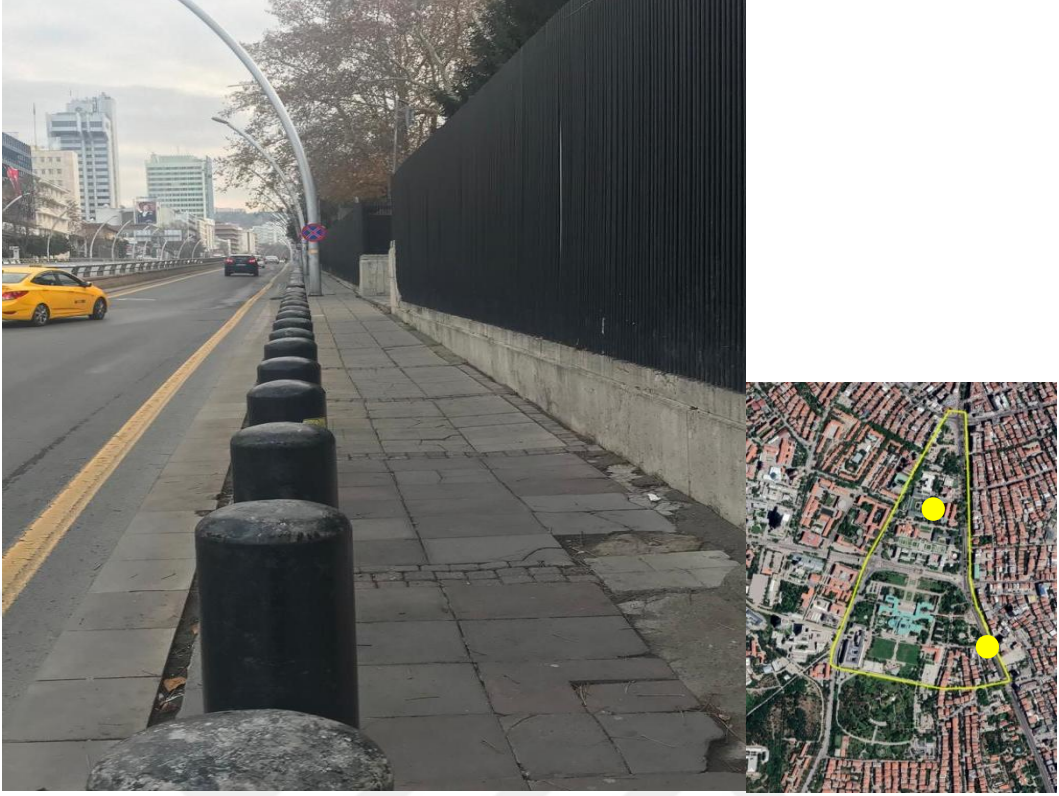
Görsel 84. (Kaynak: kişisel arşiv) Atatürk Bulvarında yaya kaldırım uygulamasında hareket etme zorlukları bulunmaktadır. Yürüme zorluğu yaratan bakımsızlık ve güvenlik amaçlı mantarlar görülmektedir.
