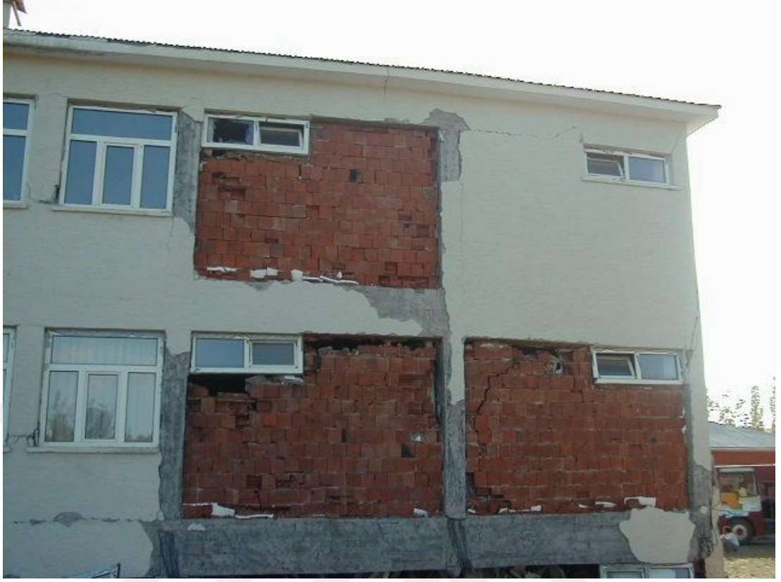
Şekil 5.10 Güçlü Kiriş Zayıf Kolon Düzensizliği
