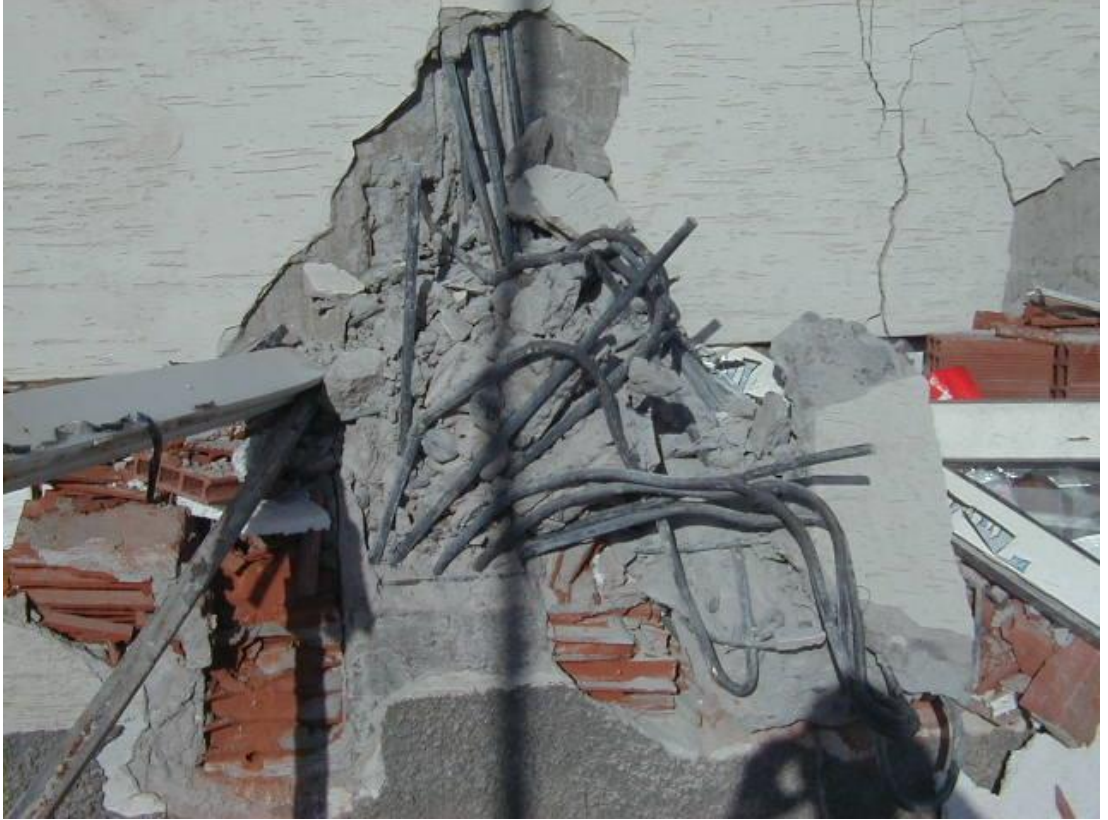
Şekil 5.7 Uygunsuz Granülometri
