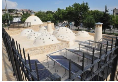
Çukur Hamamı çatı görünüşü (Kalli, 2023)
