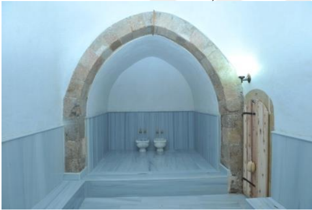
Ilıklık Bölümü Restorasyon Sonrası (Maraş Büyükşehir Belediye Arşivi)
