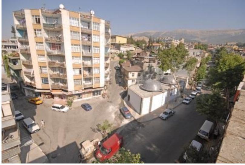
Şekil 4.51. Uzunluk hamamı görünüşü (Kahramanmaraş Büyükşehir Belediyesi Arşivi, 2022)
