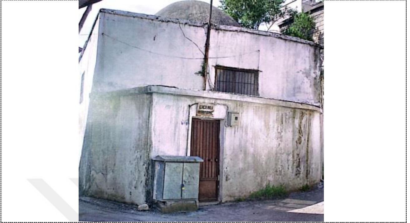
Çiçekli hamamı görünüşü (Kahramanmaraş Belediyesi, 2012)
