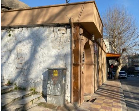
Batı Görünüşü (Büşa Kalli, 2023)
