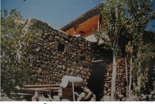
Doğu Cephesi (Özkarcı, 2007)
