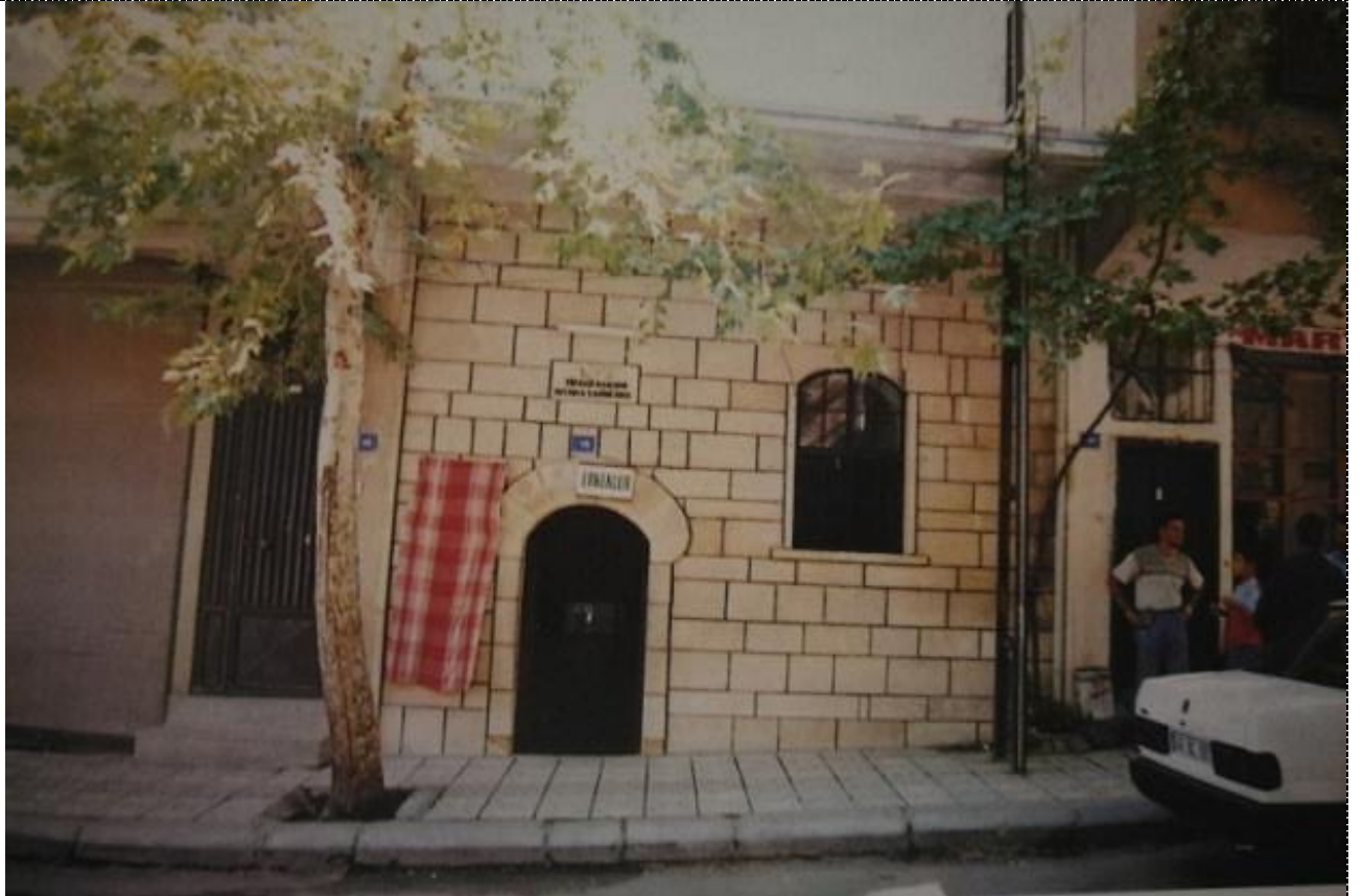
Tüfekçi hamamı, 2007 yılına ait güney cephe görünüşü (Özkarıcı, 2007)
