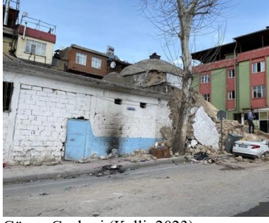
Güney Cephesi (Kalli, 2023)
