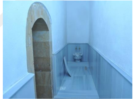
Aralık Bölümü Restorasyon Sonrası (Maraş Büyükşehir Belediye Arşivi)
