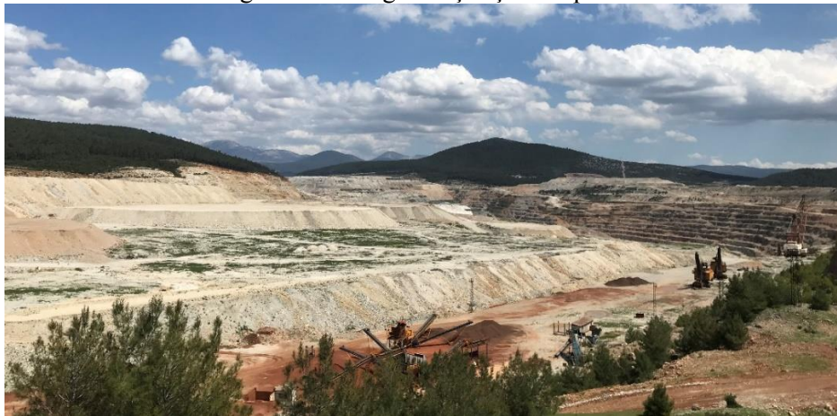
Şekil 61. Karakuyu-Tınaz Kömür Ocağı İşletmesi. Kömür Çıkarım İşlemi Tamamlanmasına Rağmen Kapatılmayıp Dış Kuvvetlere Karşı Savunmasız Halde Bırakılmıştır. Şuan Kapalı Olan Kömür Ocağında Herhangi Bir Çalışma Yapılmamaktadır.
