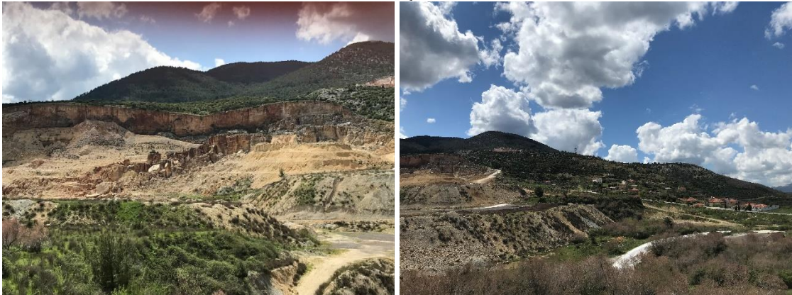
Şekil 101. Bağyaka Kömür Çıkarım Alanındaki Açık İşletmede Kömür Çıkarım İşlemi Bittikten Sonra Kapatılmadan Bırakılan Alanda Heyelanlar Meydana Gelmektedir. Meydana Gelen Heyelan Sonucunda Bağyaka Köyü Yaklaşık 2 km Kuzeye Doğru Yer Değiştirmek Zorunda Kalmıştır.
