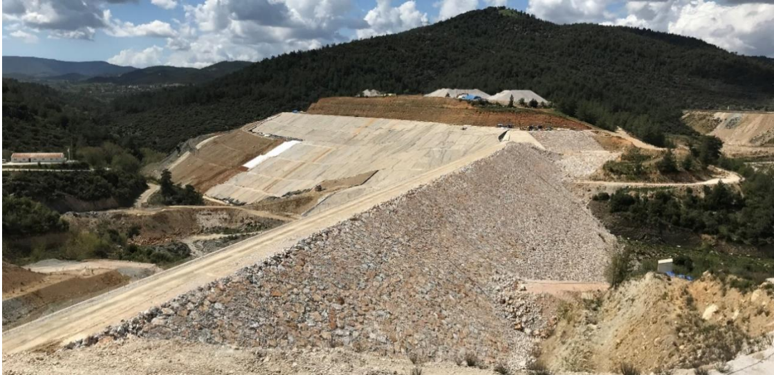
Şekil 35. Yapımı Halen Devam Etmekte Olan Girme Baraj Gölü. Barajın Yapımı Tamamlandıktan Sonra Yaklaşık 10.000 Nüfusa Su Sağlayacağı Ve 21 Bin 650 da Tarım Arazisinin Sulaması Hedeflenmektedir.
