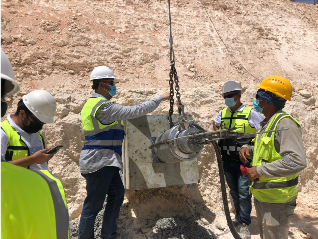
Şekil 3.17 Ankraj kabul testi uygulaması.
