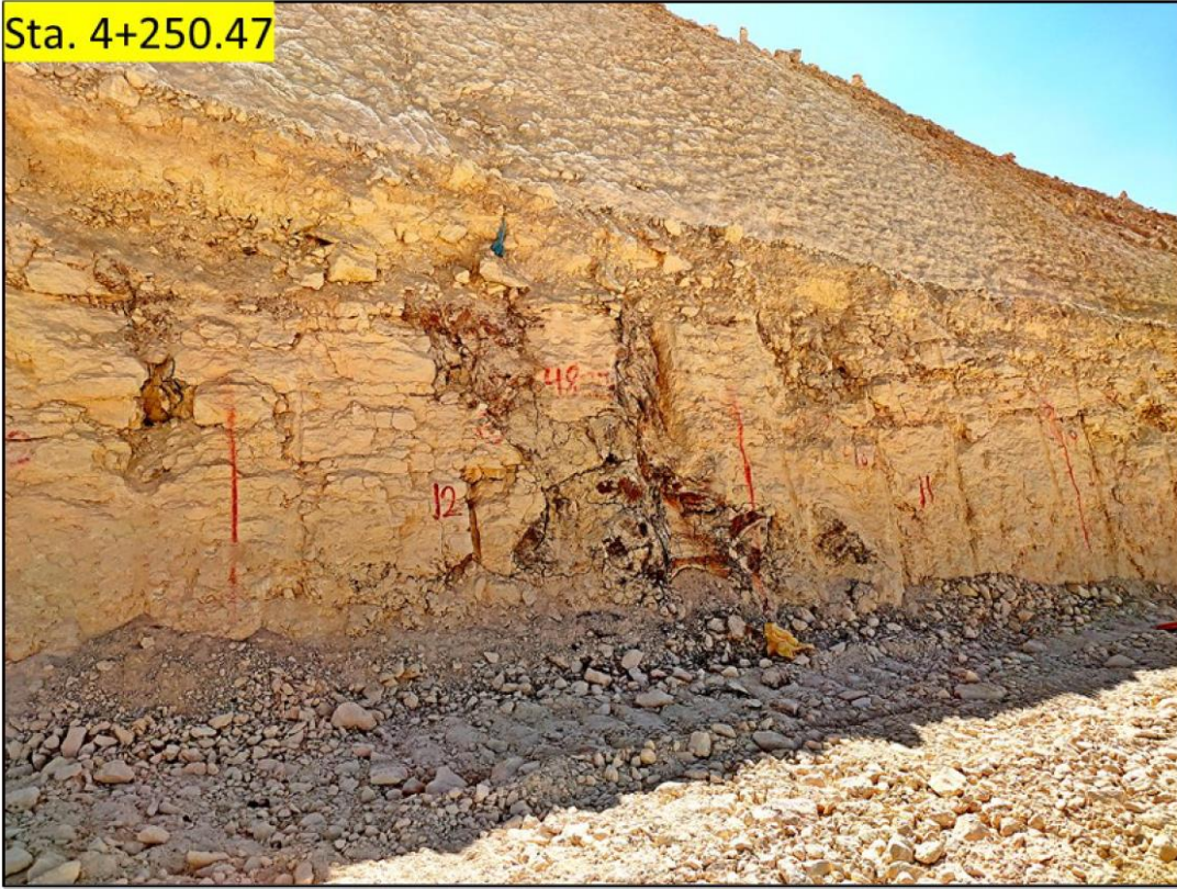
Şekil 3.1 Çalışma alanının 4+250 km'sindeki killi kireçtaşı tabakalarına ait görsel.
