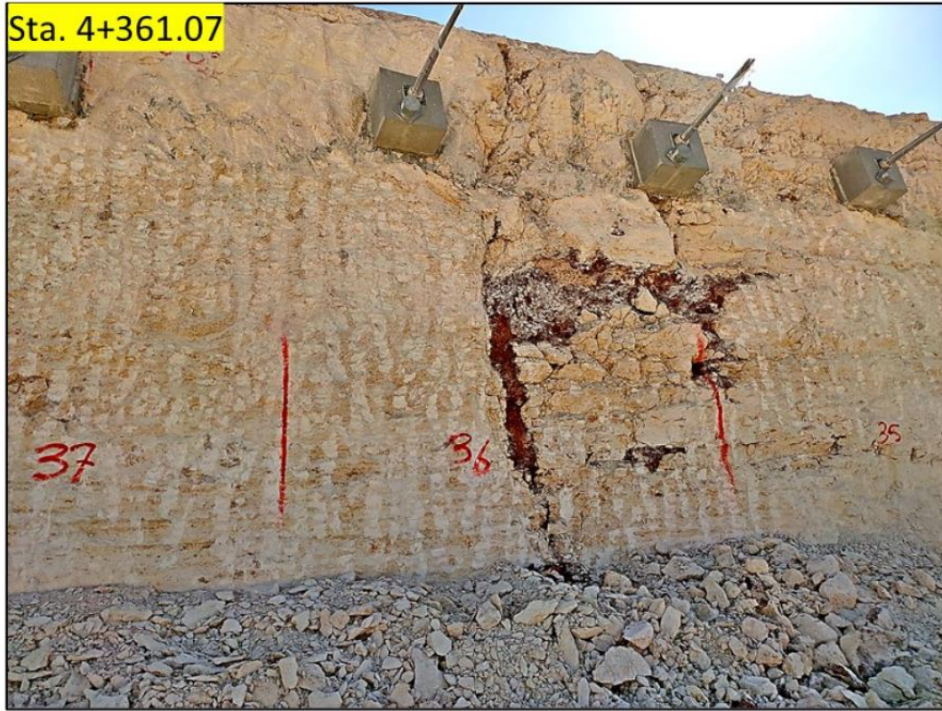
Şekil 3.2 Çalışma alanının 4+361 km'sindeki killi kireçtaşı tabakalarına ait görsel.
