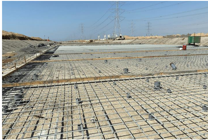
Şekil 2.4: Beton dökülecek zeminin FRP donatı ile güçlendirme [30].
