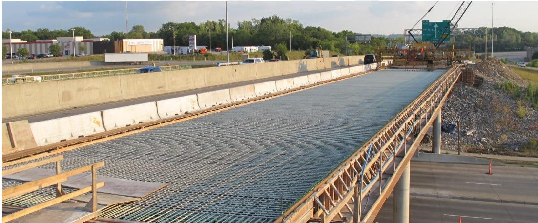
Şekil 2.5: Köprü tabliyesinde FRP donatıların kullanımı [30].
