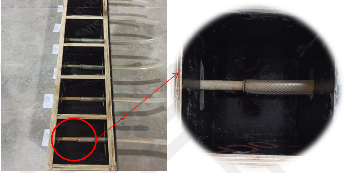
Şekil 3.15: Beton içerisinde kalacak olan kumlu GFRP donatıların kenetlenme boylarının ayarlanması.
