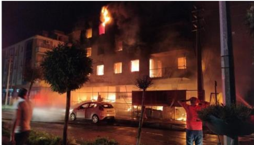
Şekil 2.10: Yapıda çıkan yangın [48].
