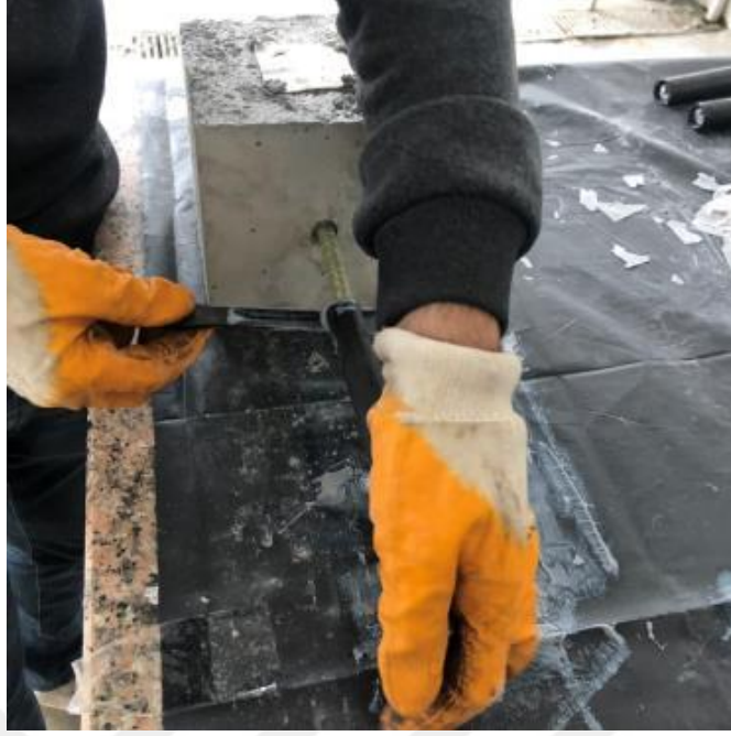
Şekil 3.31: Epoksi dolu boruların donatıya yerleştirilmesi.
