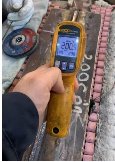
Şekil 3. 16 200°C ön ısı kontrollü kaynak sırasında lazerli sıcaklık ölçerle malzeme sıcaklığının kontrolü sırasında çekilmiş fotoğraf
