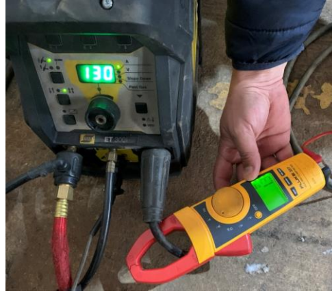
Şekil 3. 21 Kaynak makinası amper doğrulaması sırasında çekilmiş fotoğraf
