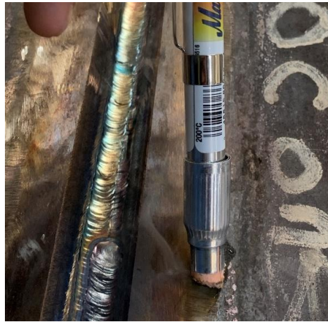
Şekil 3. 15 200°C ön ısı kontrollü kaynak sırasında 200°C ısı tebeşiri ile malzeme sıcaklığının kontrolü sırasında çekilmiş fotoğraf
