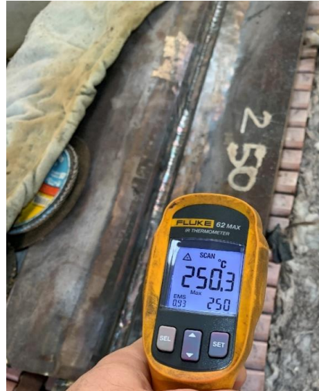
Şekil 3. 19 250°C ön ısı kontrollü kaynak sırasında lazerli sıcaklık ölçerle malzeme sıcaklığının kontrolü sırasında çekilmiş fotoğraf
