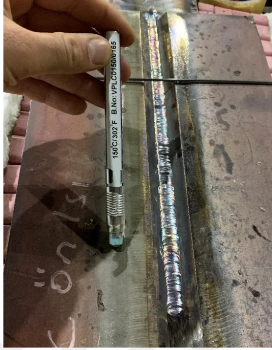
Şekil 3. 12 150°C ön ısı kontrollü kaynak sırasında 150°C ısı tebeşiri ile malzeme sıcaklığının kontrolü sırasında çekilmiş fotoğraf
