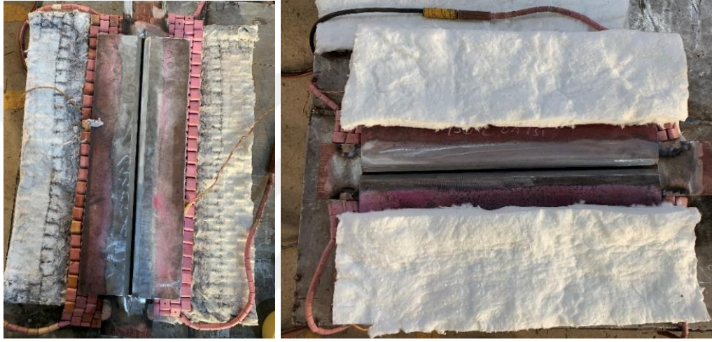
Şekil 3. 8 Kaynak öncesi ve sırasında ısıtma ve sıcaklık kontrolünün sağlanması için kurulan ısıtıl işlem düzenekleri
