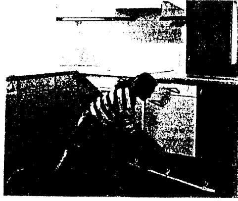
Alt eteklerin montajı
