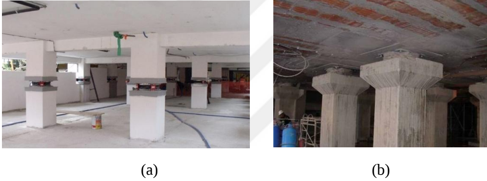
Şekil 2. 11. (a), (b) Deprem İzolatörlerinin Yapıya Uygulanması (Deprem İzolatörleri, 2018)
