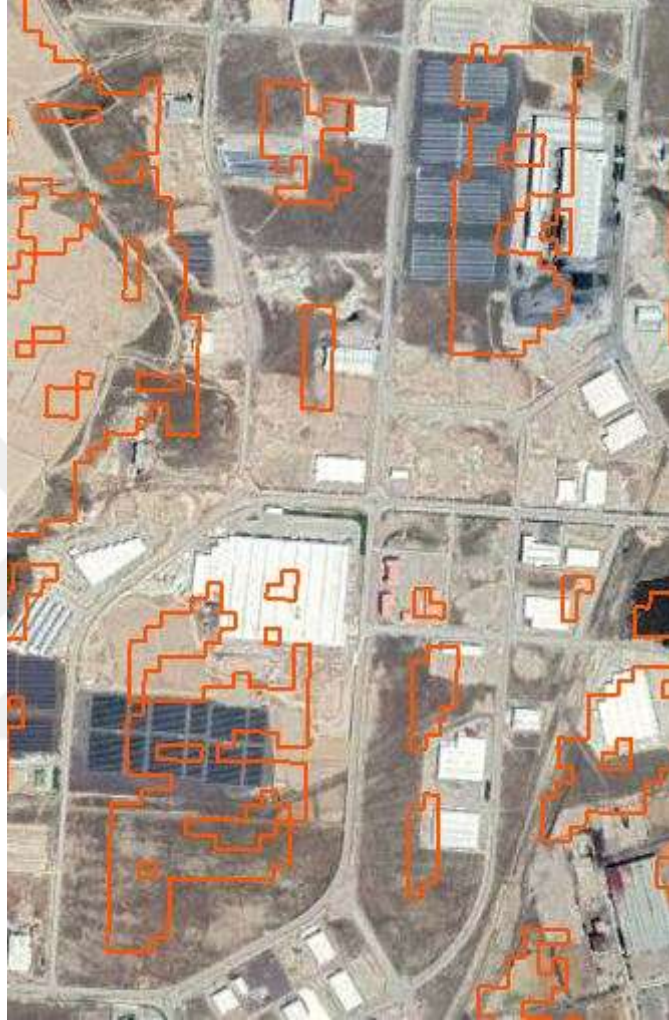
Şekil 3.7. İncesu İlçesi organize sanayi bölgesinde kurulu olan güneş enerji santrali
