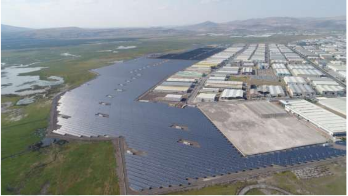
Şekil 3.3. Kayseri Organize Sanayi Bölgesi güneş enerji santralinden görüntü-2 (Url-9)
