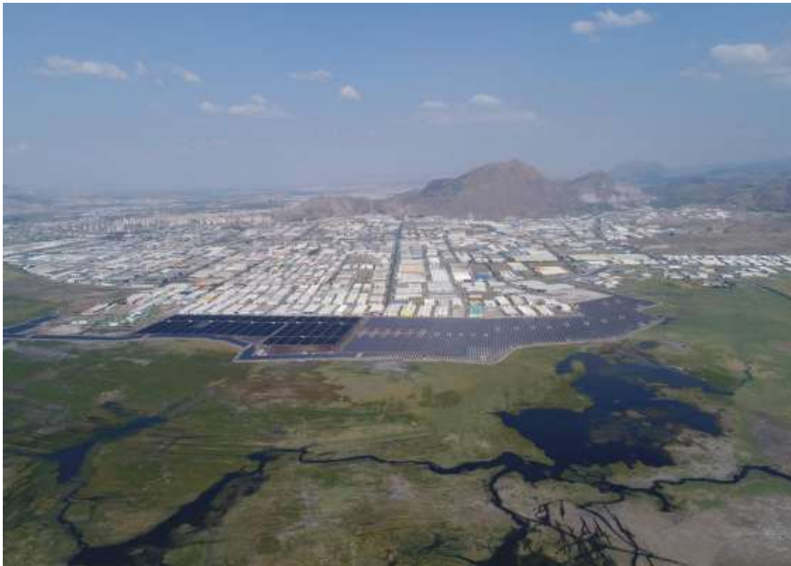
Şekil 3.2. Kayseri Organize Sanayi Bölgesi güneş enerji santralinden görüntü-1 (Url-9)
