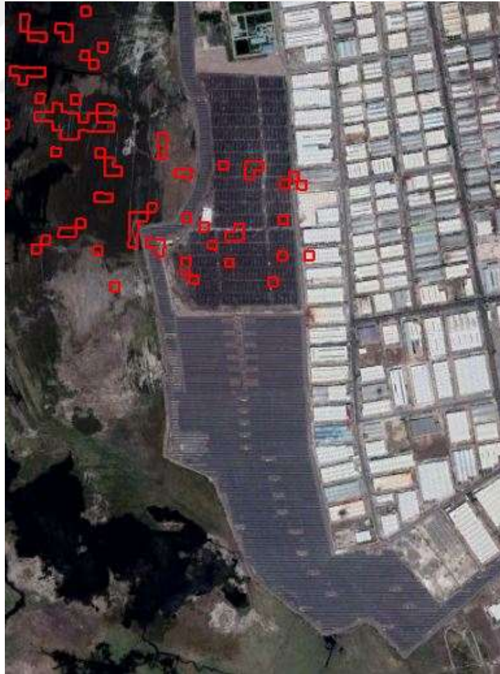
Şekil 3.4. Kayseri Organize Sanayi Bölgesi güneş enerji santrali
