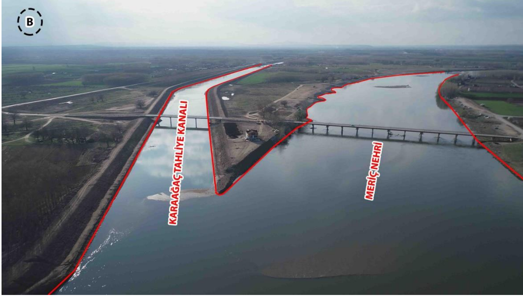
Şekil 5.17 : Tahliye kanalı bitiş noktası (Devlet Su İşleri 11.Bölge Müdürlüğü, 2019).
