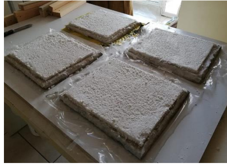
Resim 6.17b. Tesviye harcı uygulama
