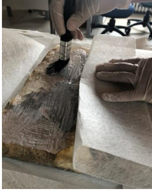
Resim 6.16a. Cam elyaf ile ayırıcı tabaka oluşturma
