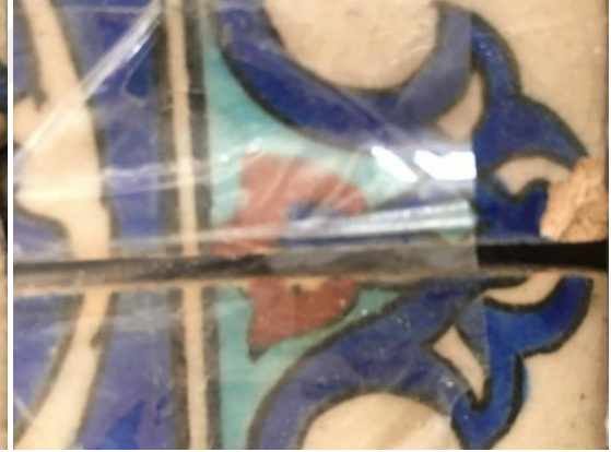
Resim 5.49. Aşınma ve kırık kenarlar
