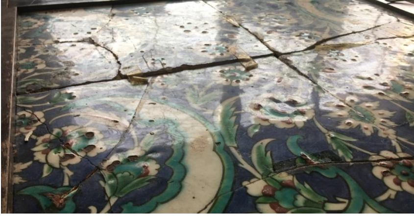
Resim 5.22. Patlamalar ve sır atmalarının yüzeyde oluşturduğu homojen olmayan görüntü
