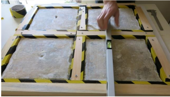
Resim 6.17.a. Tesviye harcı uygulama
