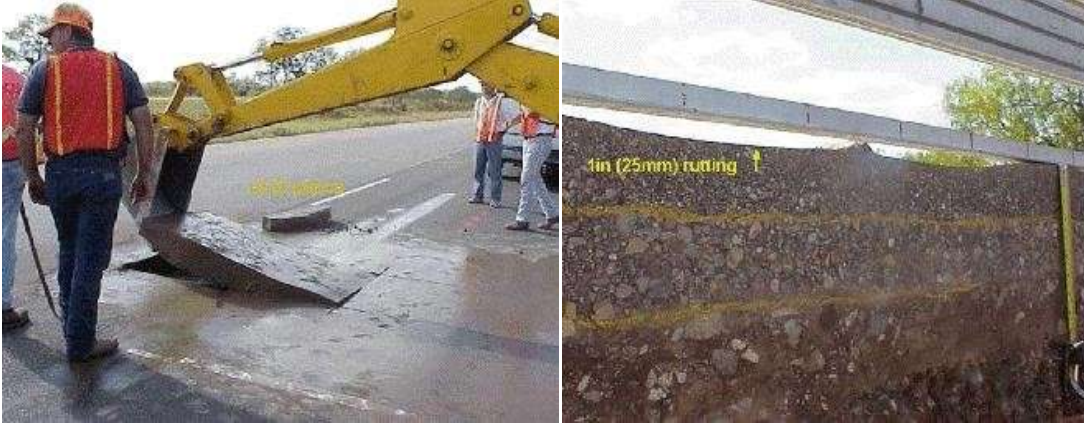
Şekil 2.5. Arazi üzerinde muayene çukuru ve kesit gösterimi (Russel vd, 2011).
