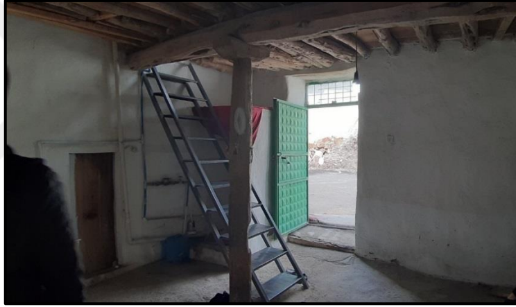
Şekil 4.110. Ömer Ali Kul konutu sofa ve taşıyıcı sistemi
