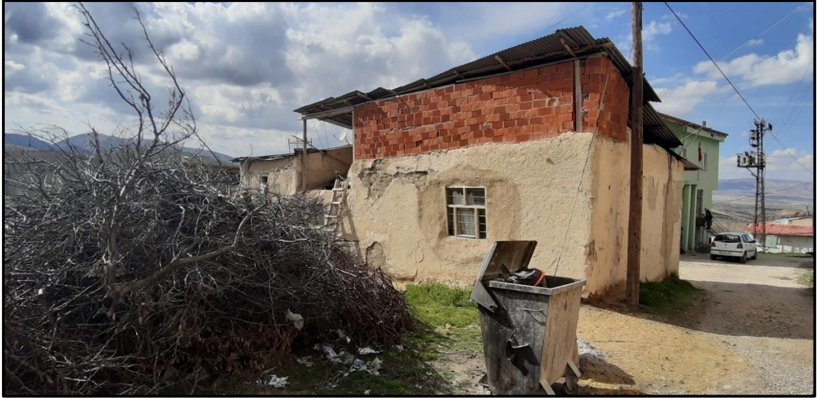
Şekil 4.107. Osman Geçer konutu çatısı ve yükseltile tuğla duvar
