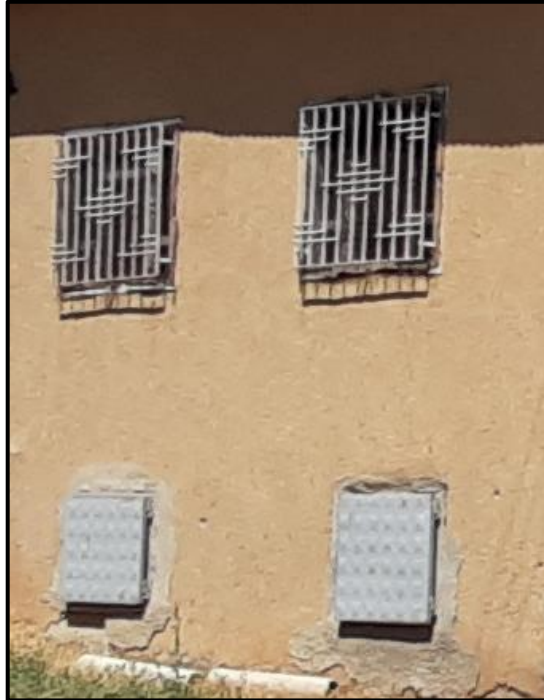
řekil 4.99. Memiř Çakmak konutu pencere demir korkuluk detayı
