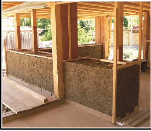
Şekil 2.20. Taşıyıcı ve bölme duvar yapımı (Çiçek, 2014)
