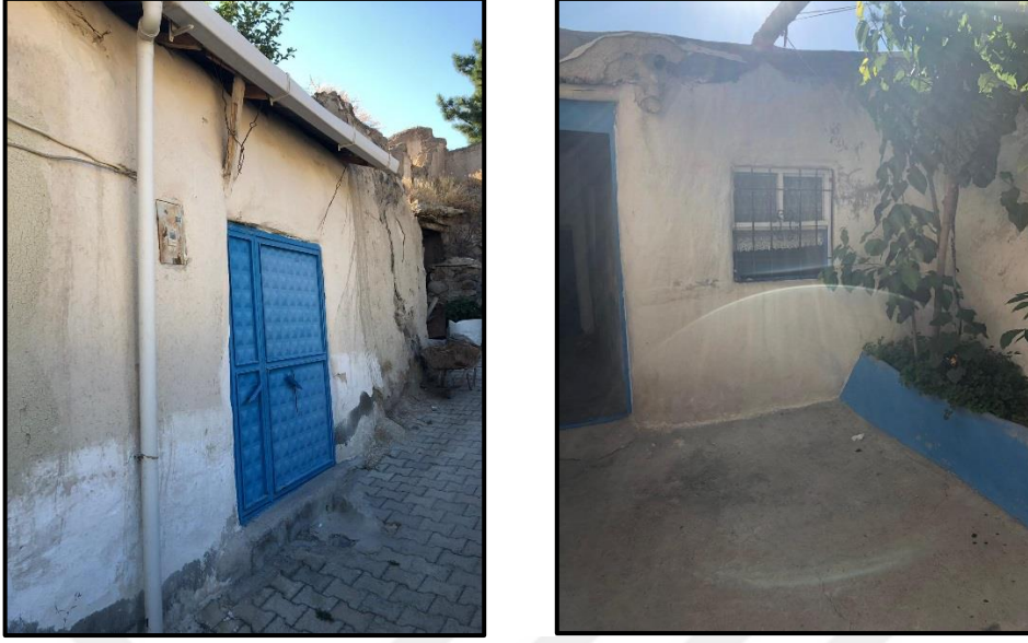
Şekil 4.65. Hamo Tezel konutu kerpiç yapı duvarları ve giriş kapısı
