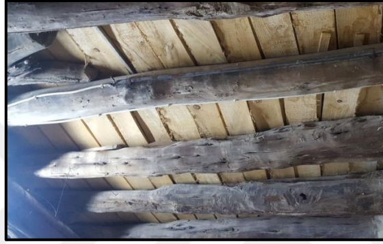
Şekil 4.43. Ali Paşa Şen konutu ahşap kaplama tahtası ve hezenler
