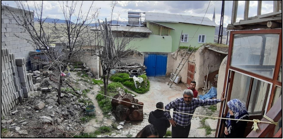
Şekil 4.117. Sevgi Deniz konutu örtmelik ve bims malzeme ile örülmüş duvarı
