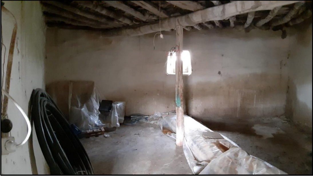
Şekil 4.114. Rüstem Parlak konutu kiriş ve ahşap dikmesi
