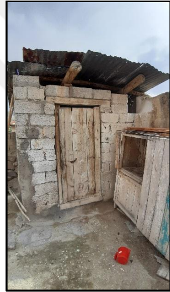
Şekil 4.48. 227 ada 8 parsel konutu hela
