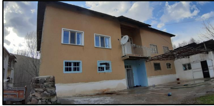
Şekil 4.90. Kenan Bak konutu ön cephesi
