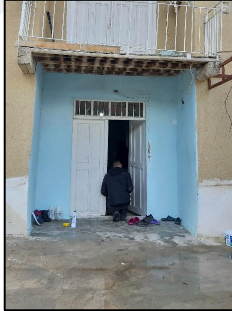
Şekil 4.89. Kenan Bak konutu giriş kapısı
