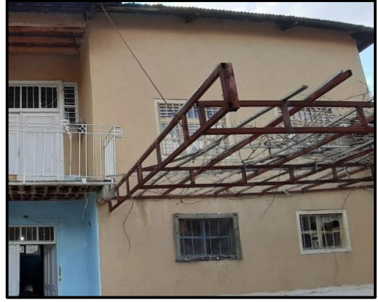
Şekil 4.92. Kenan Bak konutu bahçe üst örtüsü
