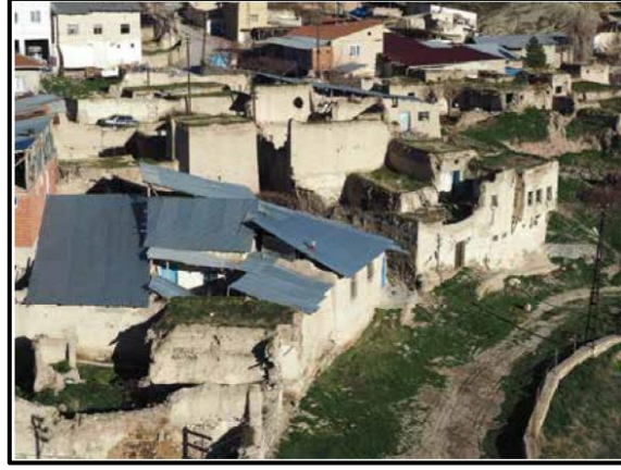
Şekil 4.28. Aşağıulupınar mahallesi sac çatı örtüleri (Gencer, 2017) 6
