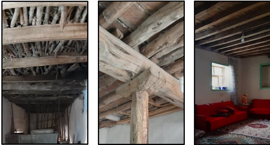
Şekil 4.22. Tavan döşeme ve taşıyıcısı
