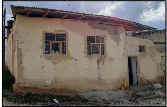
Şekil 4.106. Osman Geçer konutu ön cephesi
