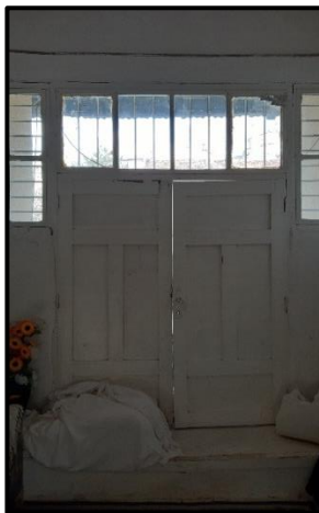
Şekil 4.93. Kenan Bak konutu sofaya açılan balkon kapısı
