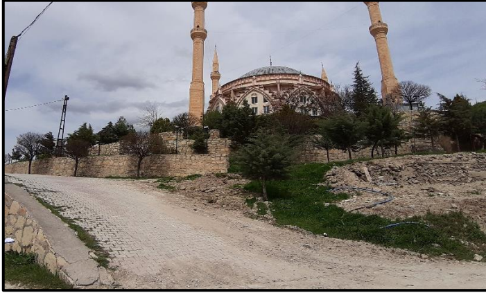
Şekil 4.39. Cami istinat duvarı
