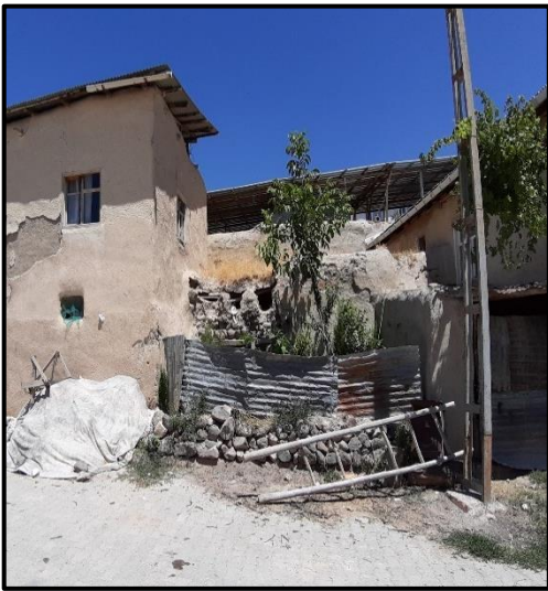
Şekil 4.85. Kadir Erden konutu çöken damı
