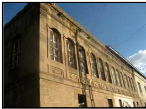
Şekil 2.30. Süsleme öğesine sahip cephe (Oğuz ve Aksulu, 2016)
