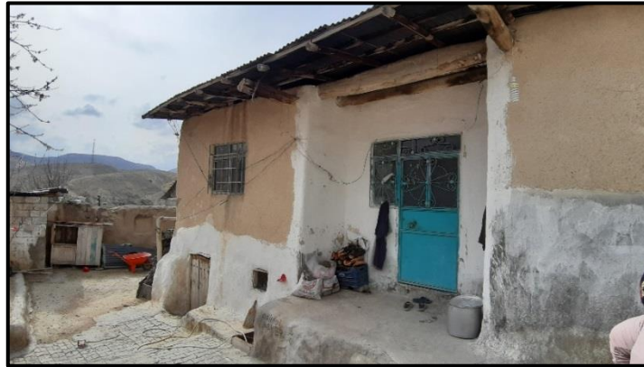
Şekil 4.46. 227 ada 8 parsel konutu ön cephe girişi
