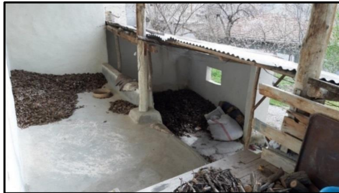
Şekil 4.55. Dönüş Çelik konutu balkon ve odunluk arasındaki geçiş
