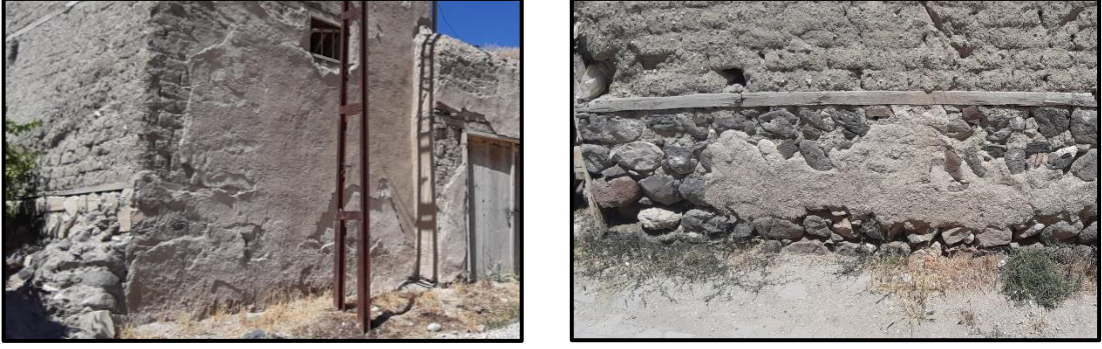
Şekil 4.19. Temel taş duvar örneği
