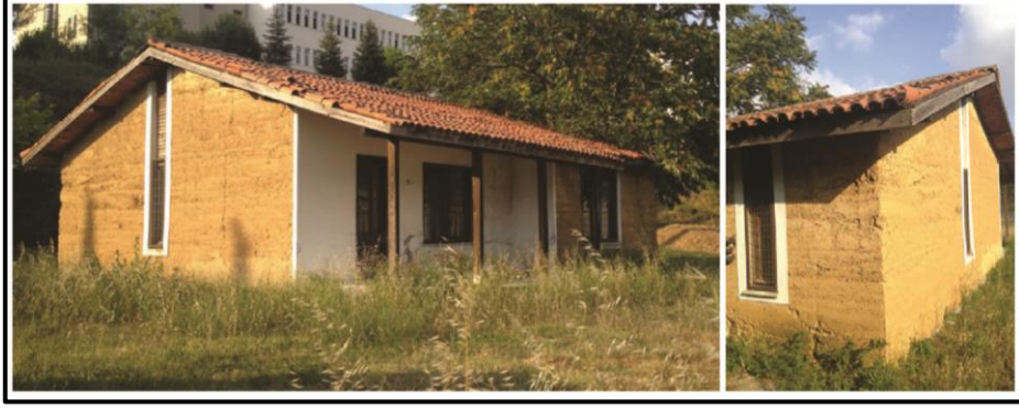
Şekil 2.16. İTÜ Alke binası (Çiçek, 2014).
