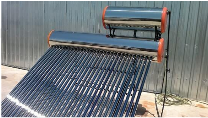
Şekil 2.1. Vakum tüplü güneş kolektörü
