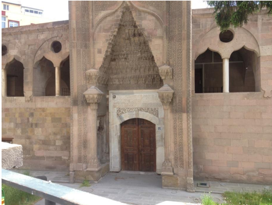
Şekil 4.6. Ak Medresenin giriş kapsından görünüm
