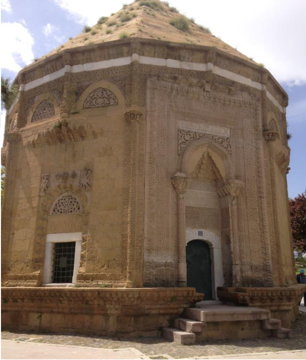
Şekil 4.7. Hüdavend Hatun Türbesinin güncel halinden görünüm
