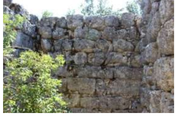
Şekil 4.1.3.3. Yapıdaki Pseudoizodom Tekniği
