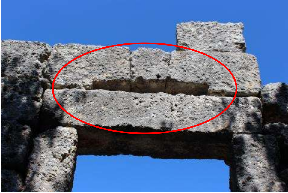
Şekil 4.1.3.11. Keşlitürkmenli Yolu Üzerinde Bulunan Çiflik Evi, Kapı Üstlerinde Bulunan Sığ Boşluklar
