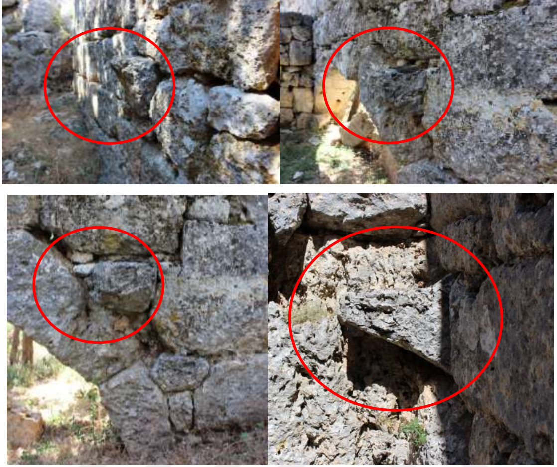
Şekil 4.1.3.6. İkinci Katın Yürüme Düzlemini Taşıyan Konsollar
