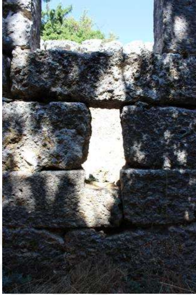
Şekil 4.1.3.7. Birinci Kata Işık Girmesini Sağlayan Mazgallara Örnek
