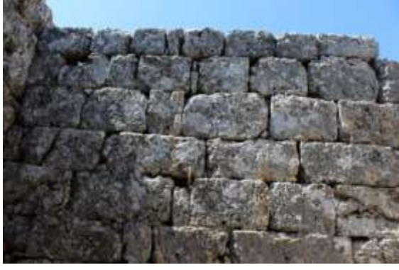
Şekil 4.1.3.2. Yapıdaki İzodom Duvar Tekniği
