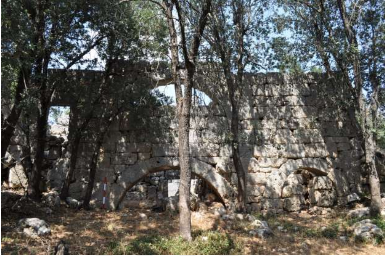
Şekil 4.1.3.5. Keşlitürkmenli Yolu Üzerinde Bulunan Çiftlik Evinin Alt Kat Kemerli Girişleri
