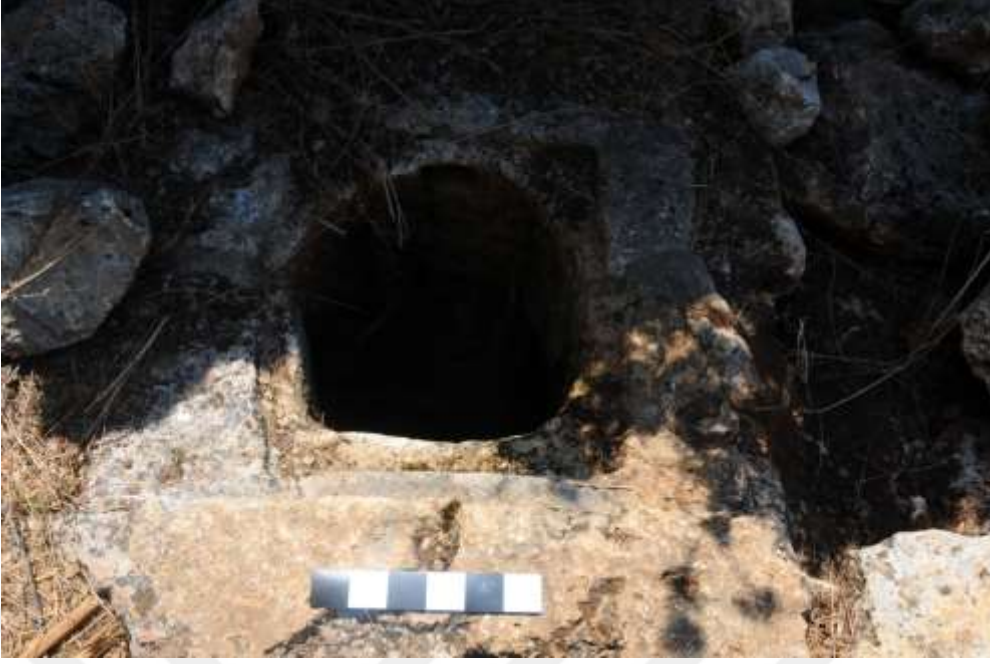
Şekil 4.3.6. Keşlitürkmenli Yolu Üzerinde Bulunan Çiftlik Yerleşimindeki Sarnıcın Kapak Bölümü
