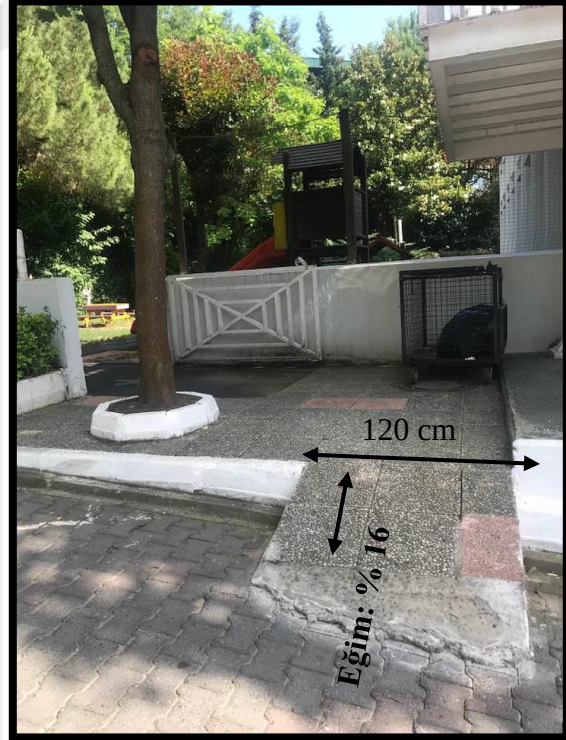
Şekil 4.30: Anaokulu girişi engelli rampası (Orij.)
