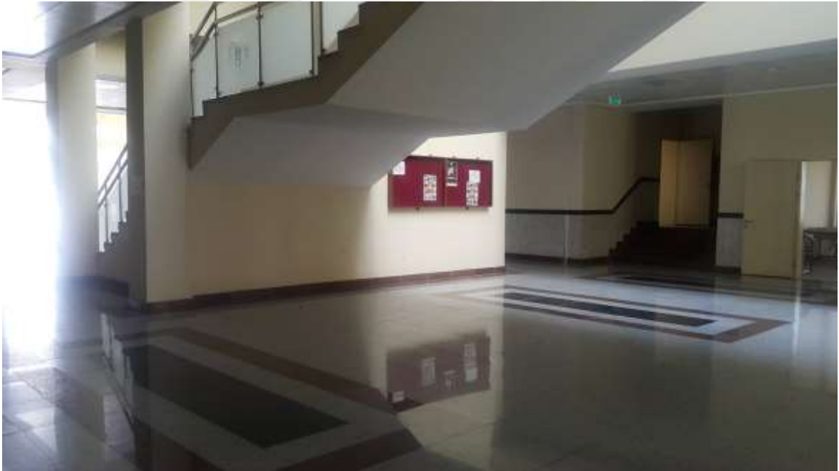
Resim 5.10. Bartın Üniversitesi Mimar Sinan Dersliği zemin kat sahanlık döşeme altı (19 Mayıs 2019 tarihinde Gülден Aslan Köse tarafından fotoğraflanmıştır.)
