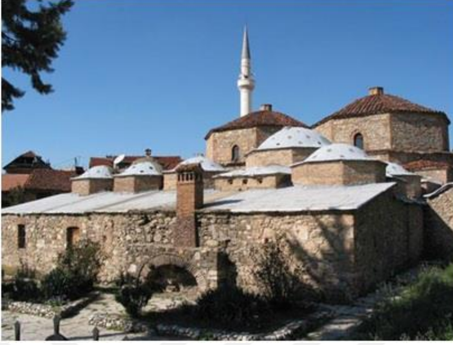
Şekil 61 Gazi Mehmed Paşa Hamamı (Osi, 2018)
