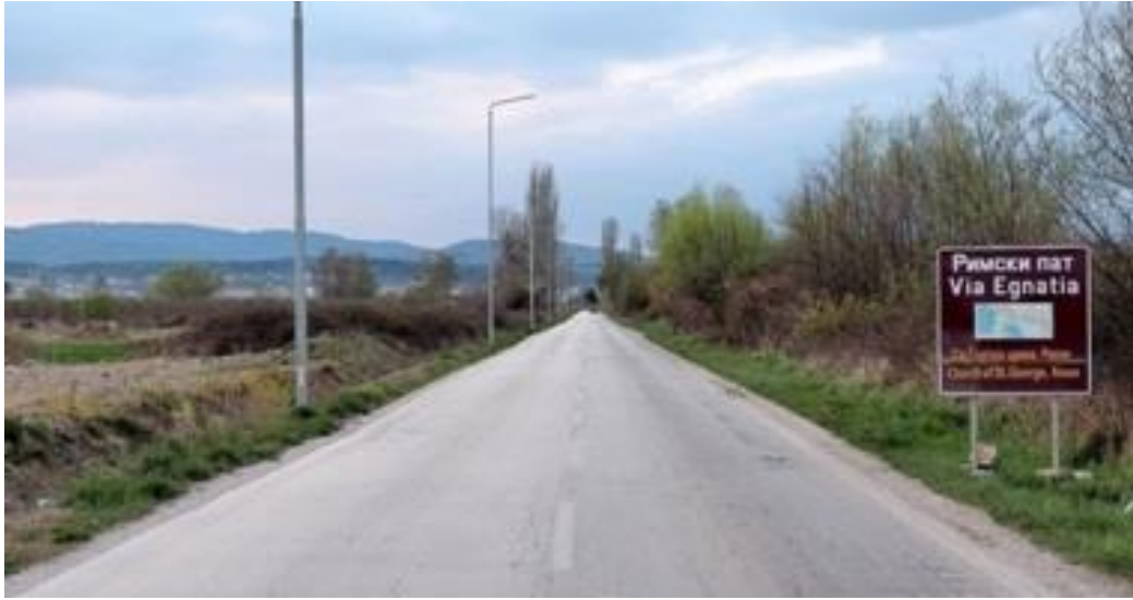
Şekil 3.2.3. Resne, Makedonya kenarındaki Egnatia Yolu, şimdilerde A-3 otoyolunun bir parçasıdır [URL-2]
