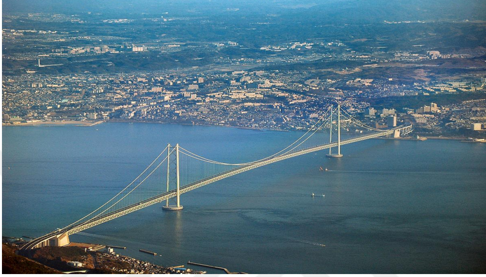
Şekil 1.1. KYB ile yapılan Akashi-Kaikyo Asma Köprüsü.
