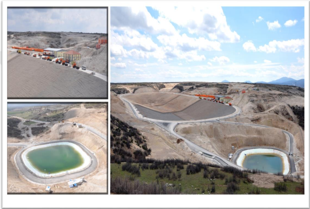
Şekil 3.2. Kütahya İli düzenli depolama sahası
