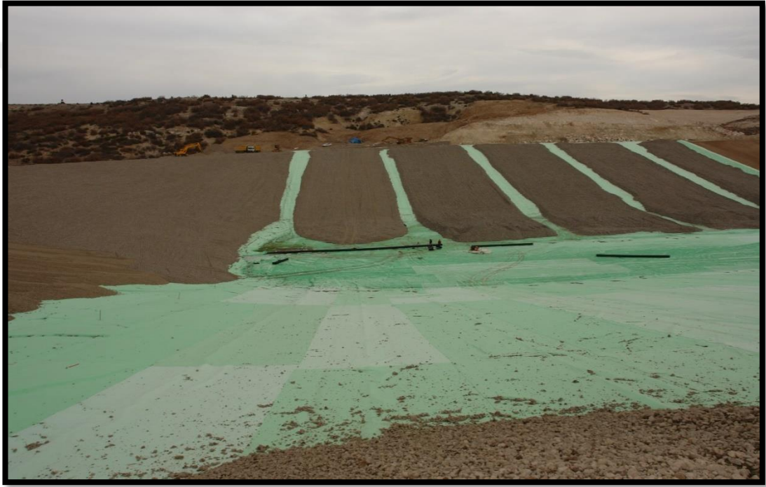
Şekil 3.1. Kütahya düzenli depolama desisi 1. lot yapımı
