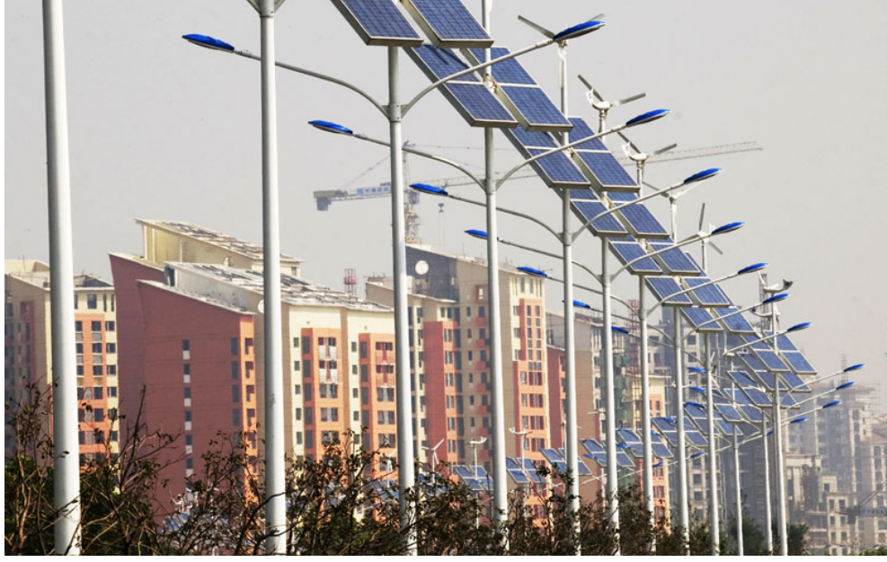
Şekil 2.14. Rüzgâr ve güneş enerjili sokak lambaları
