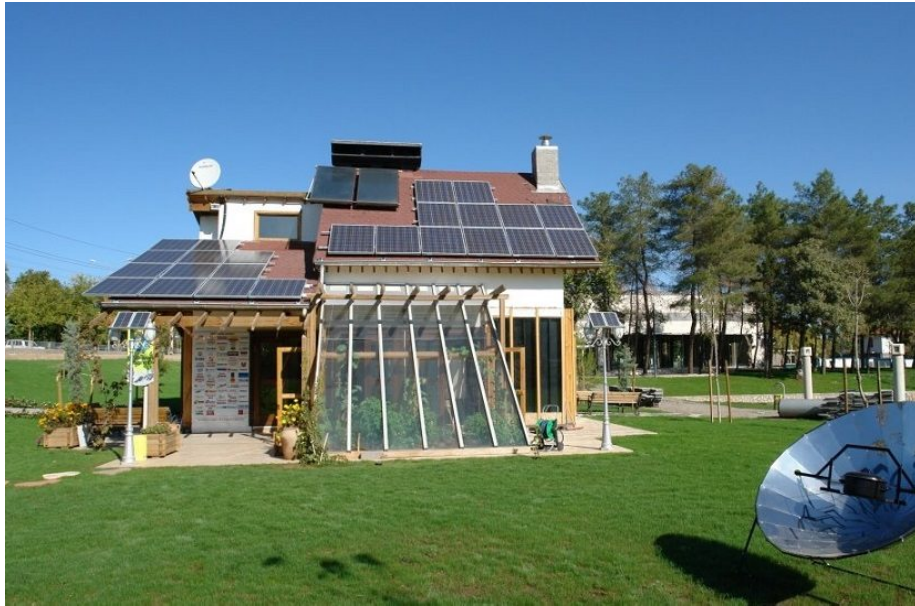
Şekil 2.20. Diyarbakır güneş evi (Url-24)
