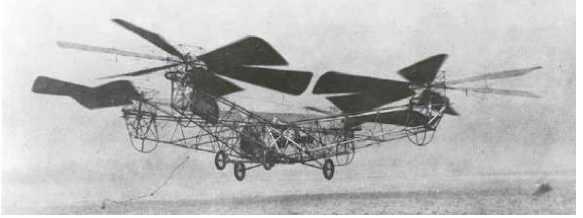
Şekil 1.2. Bothezat Quadrotoru
