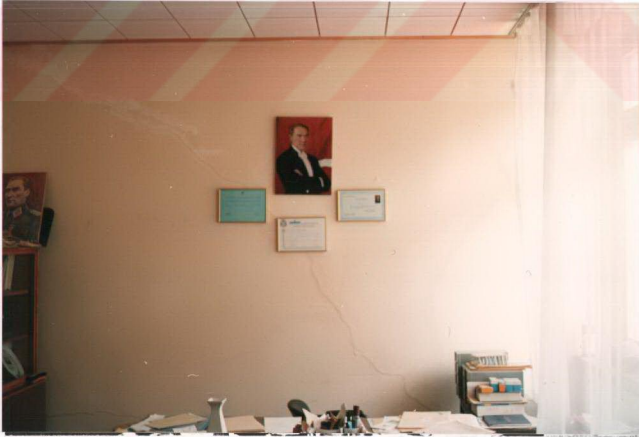
Foto 1. Kampüs alanında inşaa edilen binalardaki deformasyonlardan bir örnek fotoğraf (Jeoloji Müh. Genel jeoloji A.B.D.' ında bir öğretim üyesi odası).
