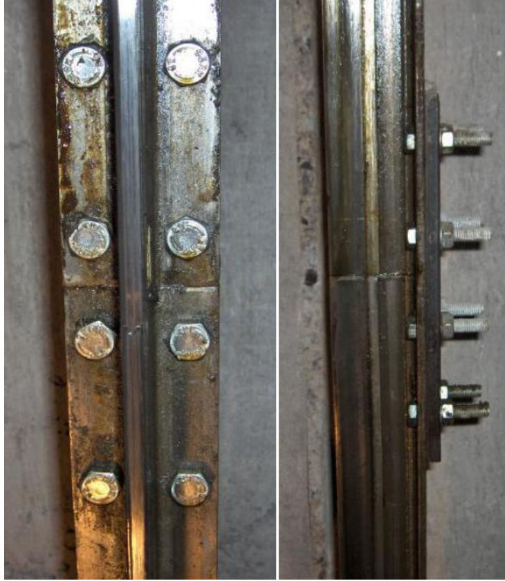
Şekil 3.4 : Kılavuz ray bağlama levhaları.
