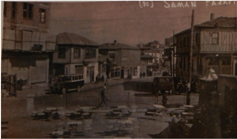
Resim 4.31. 1928 yılı Samanpazarı, Önde görünen masalı alan sonradan Esenpark olan yerin önüdür. Esen parkın bu yönünde Kavaklıdere Şaraphanesi, Tekelin dağıtım yeri, onun yanında Zaim Esentürk Kuruyemişçisi vardır. [Cangır, 2008]
