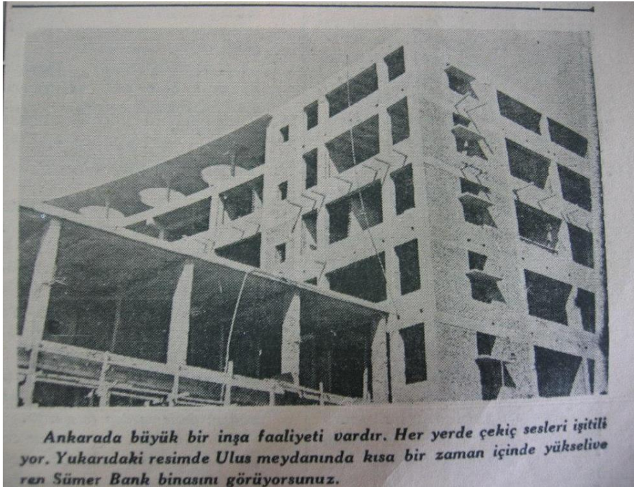
Resim 4.45. Sümerbank Binası İnşası [Ulus,1937]
