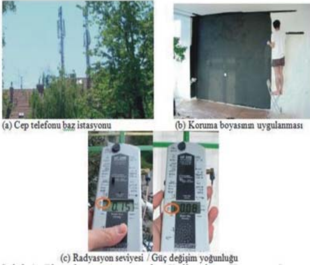
Şekil 2.6. Ekranlama amacı ile kullanılan koruma boyası uygulaması
