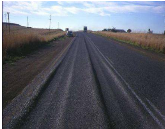
Resim 3.1. Esnek üstyapıda oluşan tekerlek izi bozulması
