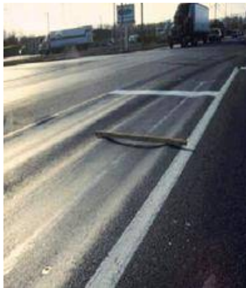
Resim 3.1. Esnek üstyapıda oluşan tekerlek izi bozulması
